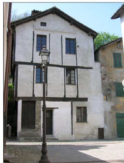
Figura 4-59 la Casa del Tranquillo, lungo la Via Interiore in Arquata Scrivia
