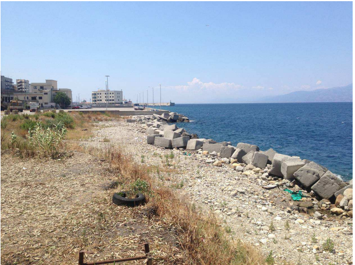
Figura 30 – Panoramiche dell'area costiera interessata d'intervento in cui si può notare l'eccessivo stato di degrado
