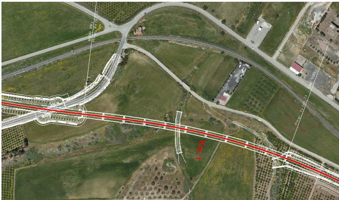
FIGURA 10 - VIADOTTO IN CORRISPONDENZA DELL'AREA AD ALTA PERMEABILITÀ A EST DELL'ABITATO DI CATENANUOVA
