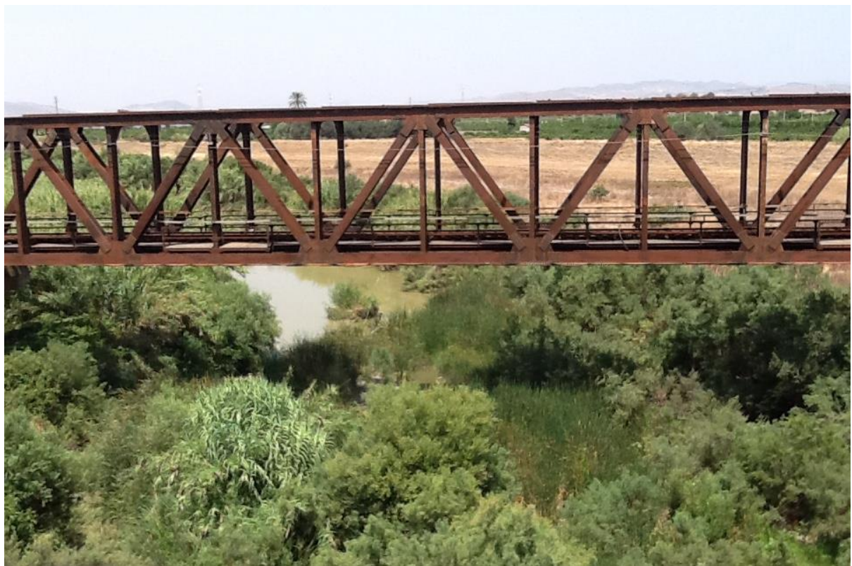
FIGURA 15 - PONTE ESISTENTE IN CORRISPONDENZA DELL'ATTRAVERSAMENTO DEL FIUME SIMETO.
