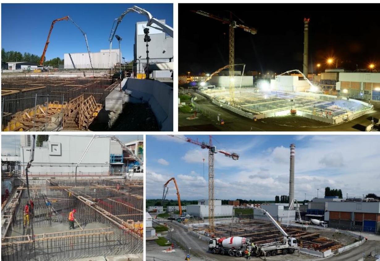
Figura 2-4 Sequenza operativa della posa in opera del getto fondazionale
