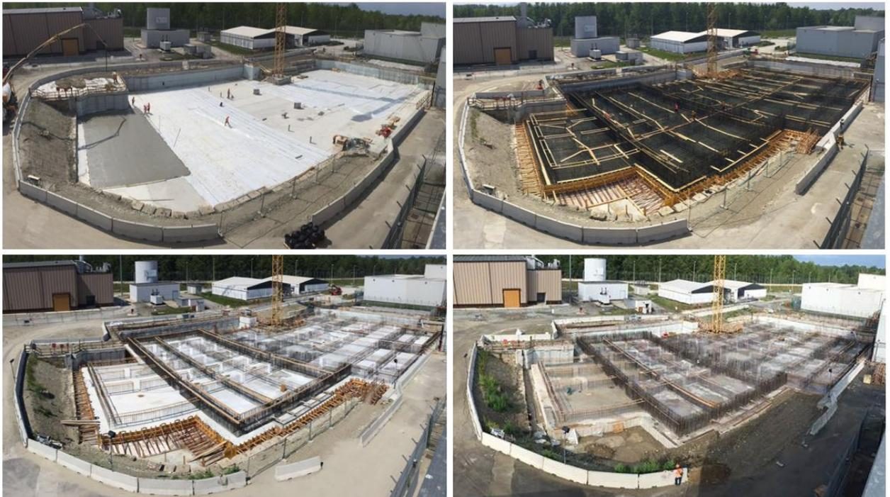
Figura 2-5 Layout di cantiere nelle diverse fasi relative alla realizzazione della platea fondazionale
