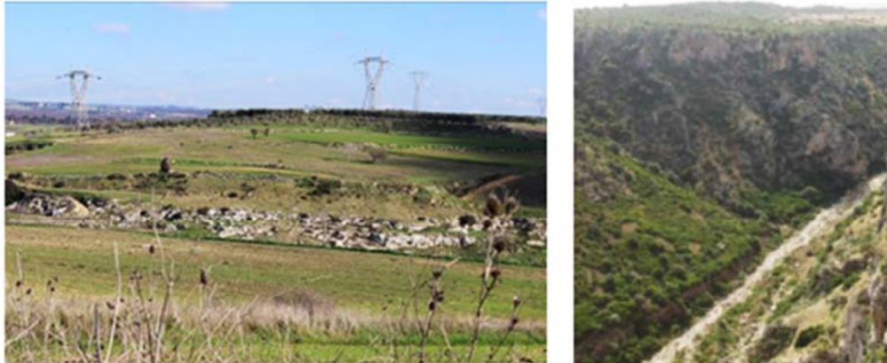
Figura 3 - La Gravina di Castellaneta come si presenta all'altezza dell'intersezione con l'elettrodotto in progetto (a sinistra) e più a valle (a destra).
