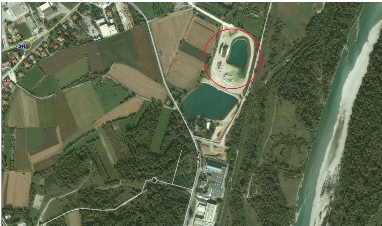
Figura 17: Ubicazione dell'impianto della ditta Edilfognature Srl . Foto satellitare
