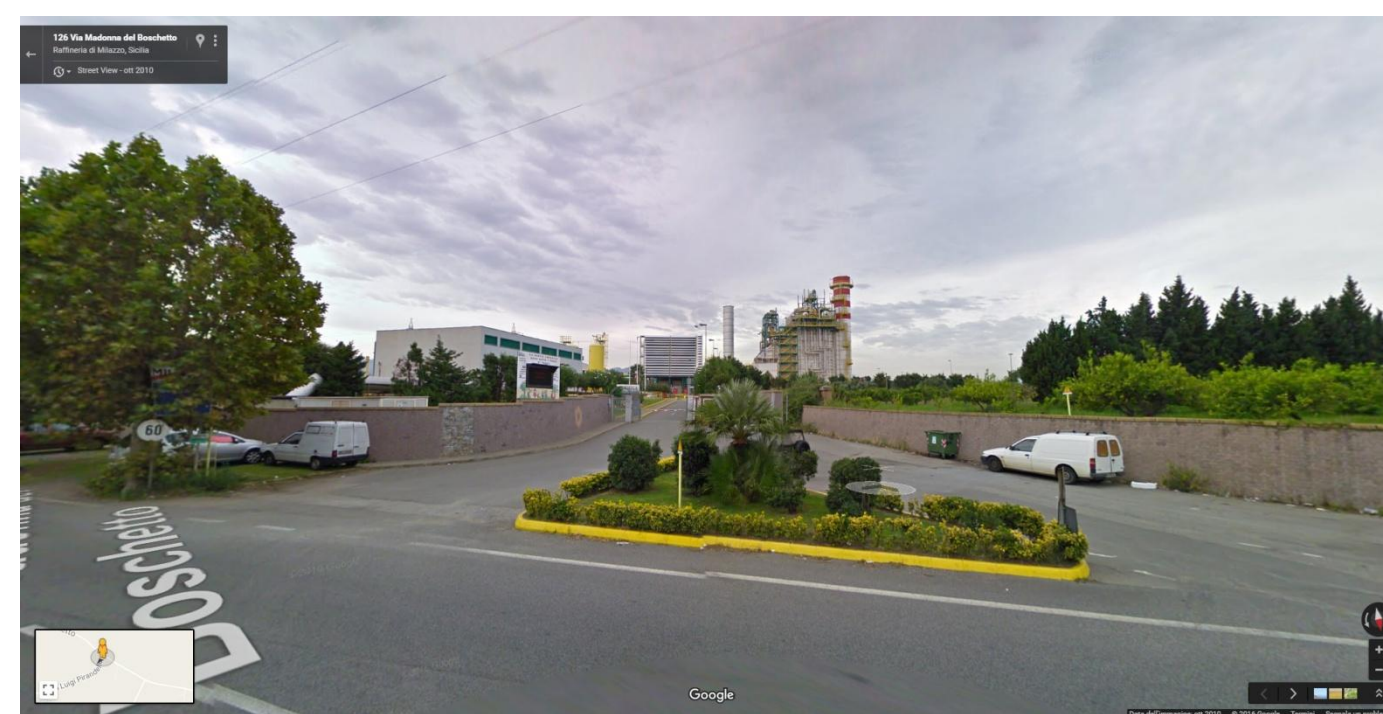
Vista della Centrale termoelettrica ex Edison dalla Strada Provinciale (immagine tratta dal sito google maps - street view)
