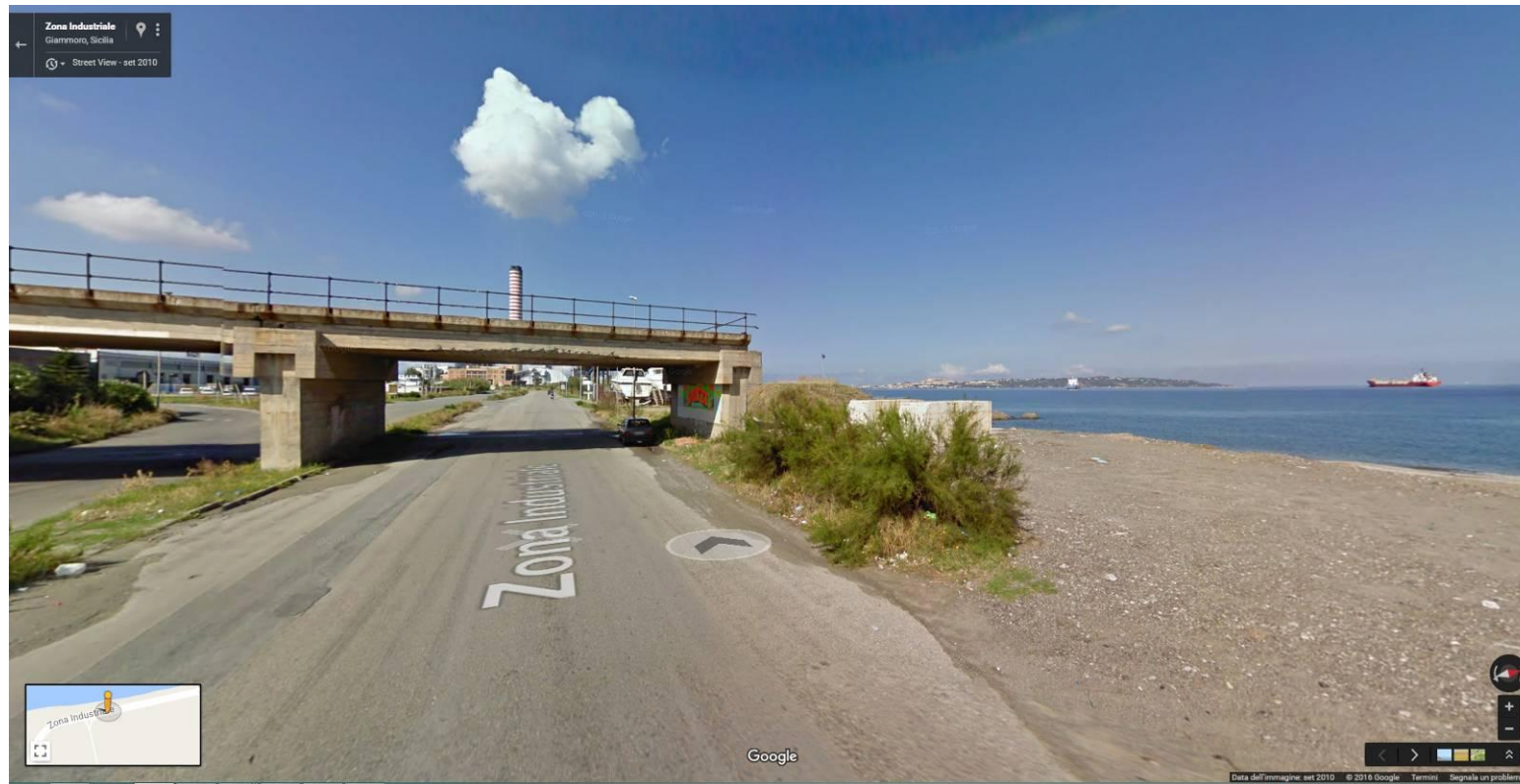
Vista del viadotto d'accesso al pontile di previsione ASI (immagine tratta dal sito google maps - street view)
