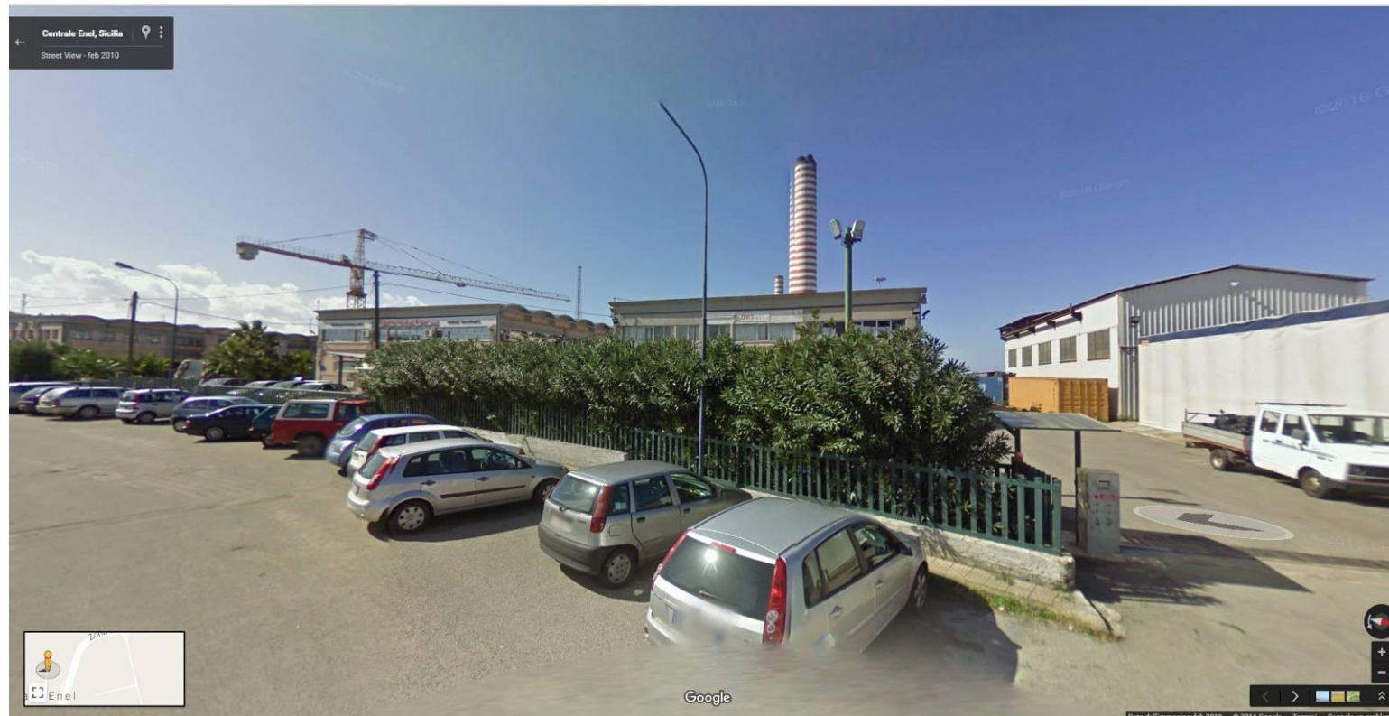
Vista dell'edificato e dell'area industriale e della retrostante CTE A2AEnergiefuture (immagine tratta dal sito google maps - street view)
