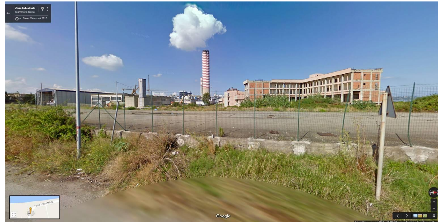
Vista dell'edificato e dell'area industriale CTE A2AEnergiefuture (immagine tratta dal sito google maps - street view)
