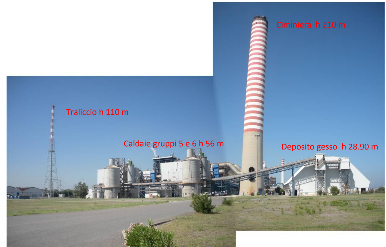
Vista delle ciminiere, del traliccio e del deposito del gesso
