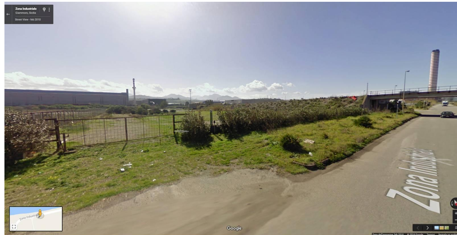
Vista del viadotto d'accesso al pontile di previsione ASI e della massciata del terrapieno della strada (immagine tratta dal sito google maps - street view)
