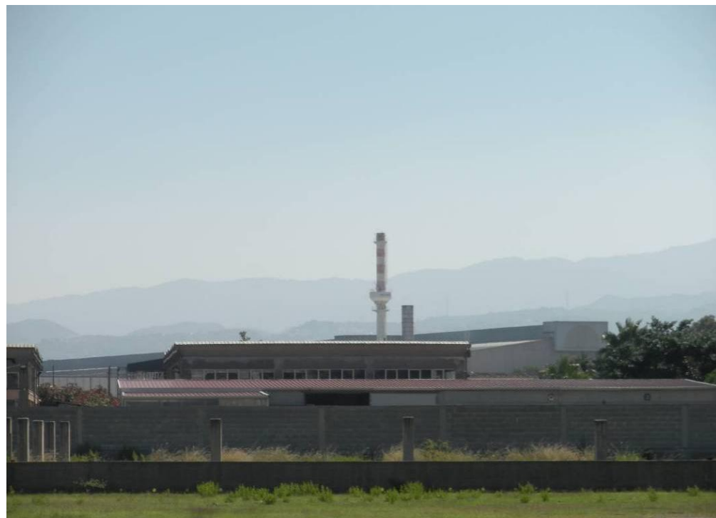
Vista dell'area industriale e della ciminiera dell'acciaieria dall'area d'intervento
