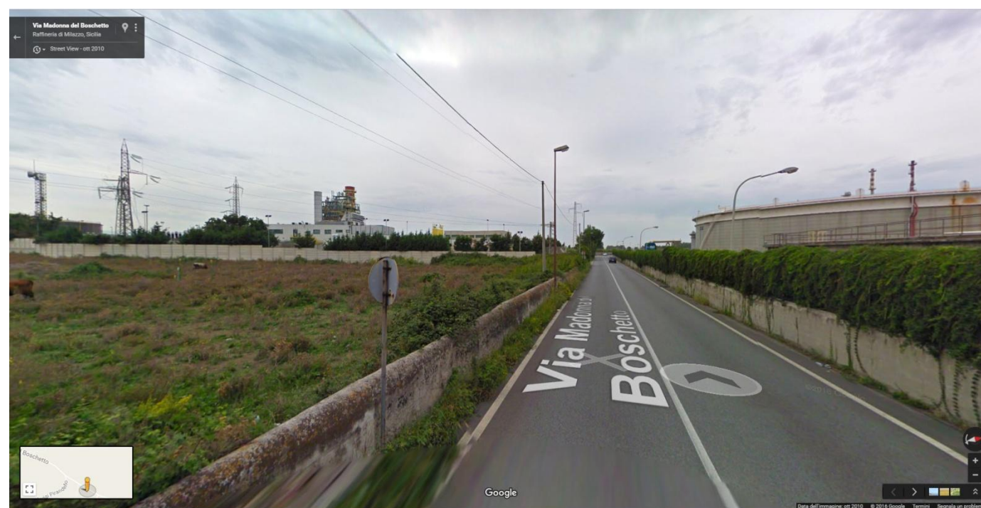
Vista della Centrale termoelettrica ex Edison e della Raffineria (immagine tratta dal sito google maps - street view)
