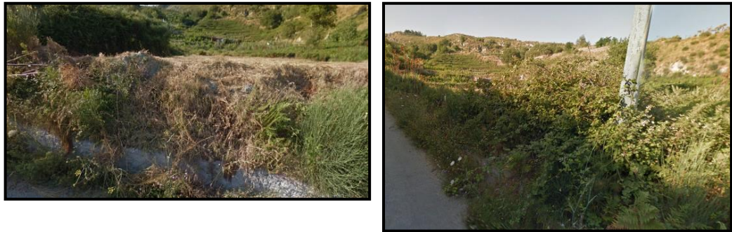
Figura 2.5.1f Vista dell'area dell'Impianto ORC in periodo estivo
