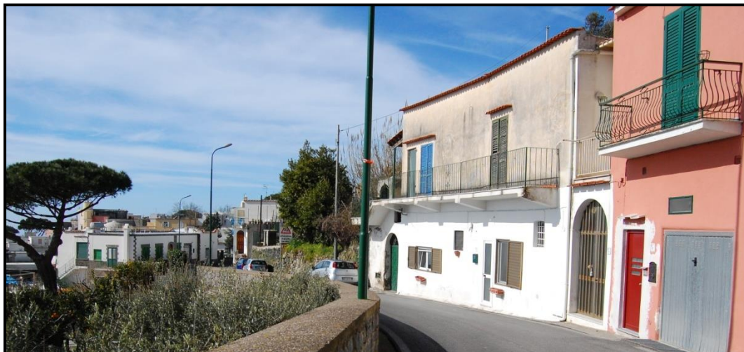
Figura 2.3.3c Edificato in Affaccio Diretto sulla Strada nei Pressi di Serrara Fontana
