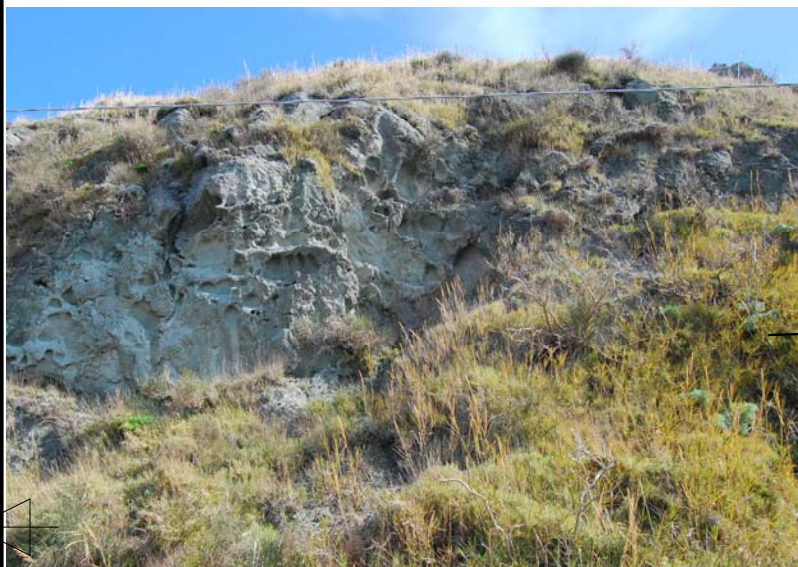
Vista scarpata esistente
