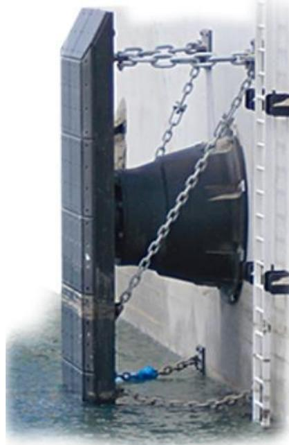
**Figura 4.6: Foto di un Parabordo**
