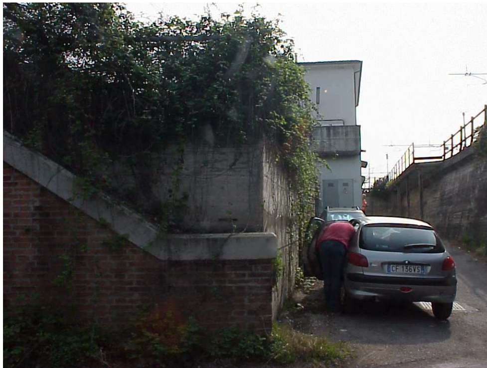
Figura 29 – Edificio Fenilone – Punto di presa posto immediatamente a Ovest del manufatto
