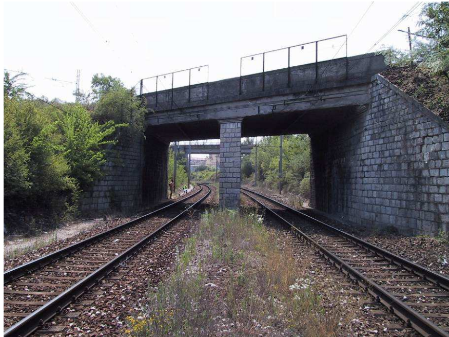
Figura 45 – Scavalco della attuale linea storica – Punto di presa posto a Nord lungo la linea Brennero-Verona scalo
