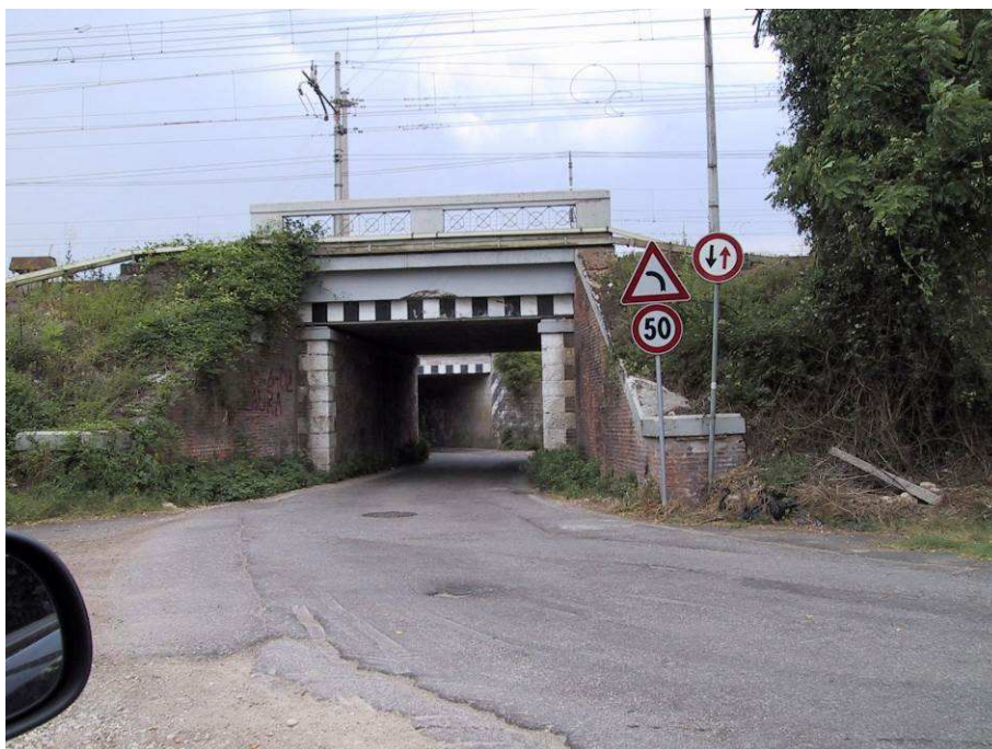
Figura 28 – Attraversamenti attuali di Via Carnia – Punto di presa posto a Nord
