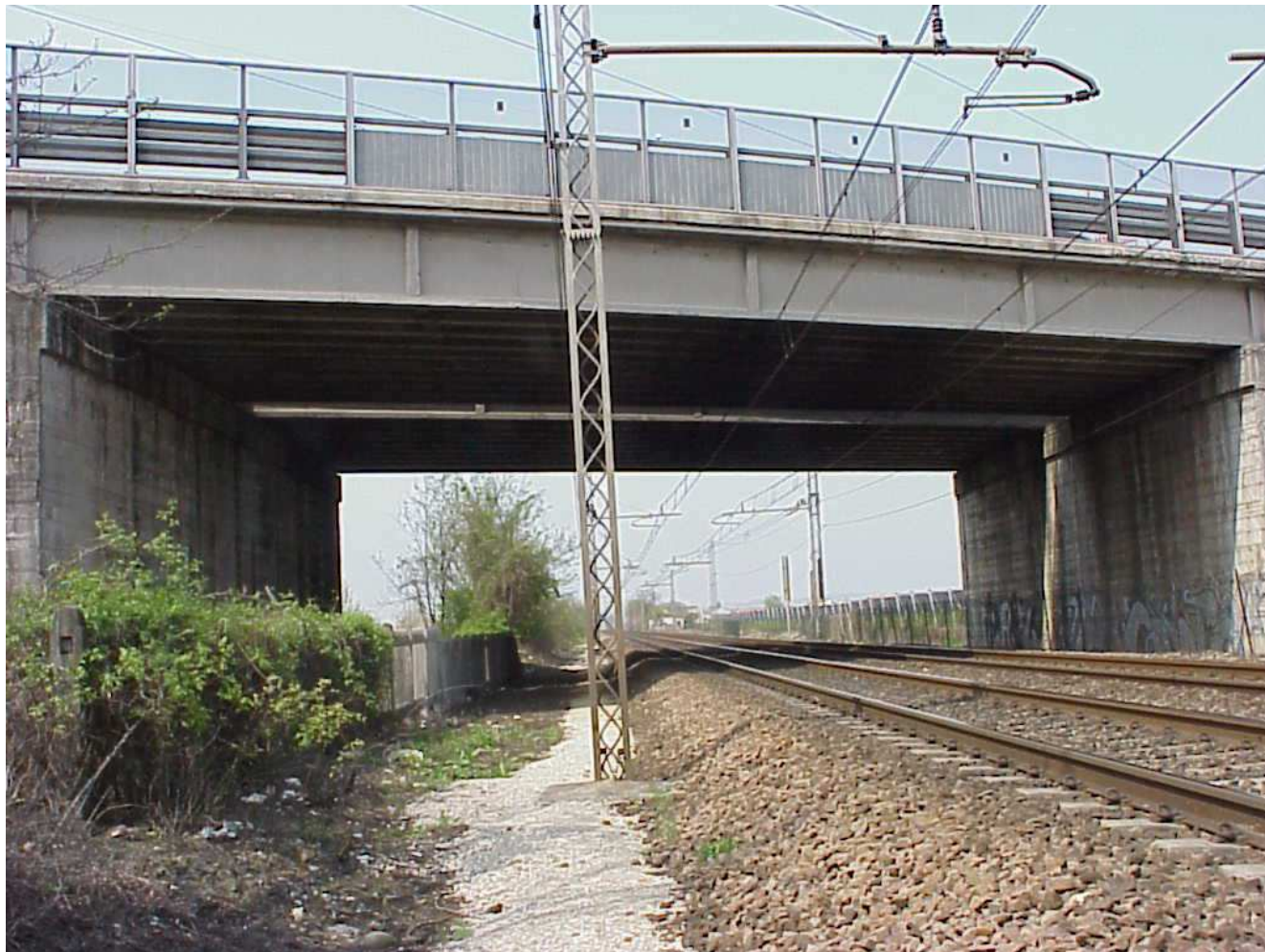
Figura 2 – Galleria linea storica per l'attraversamento del rilevato della A22 – Punto di presa a Est lungo la linea
