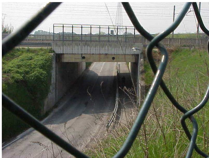
Figura 7 – Attraversamento di Via Cason – Punto di presa posto a Nord del manufatto, lungo Via Cason
