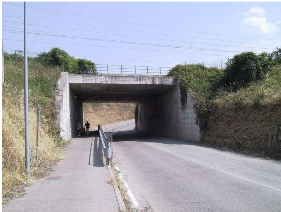
Figura 11 – Attraversamento di Via Cason – Vista Sud-Est, lungo Via Cason
