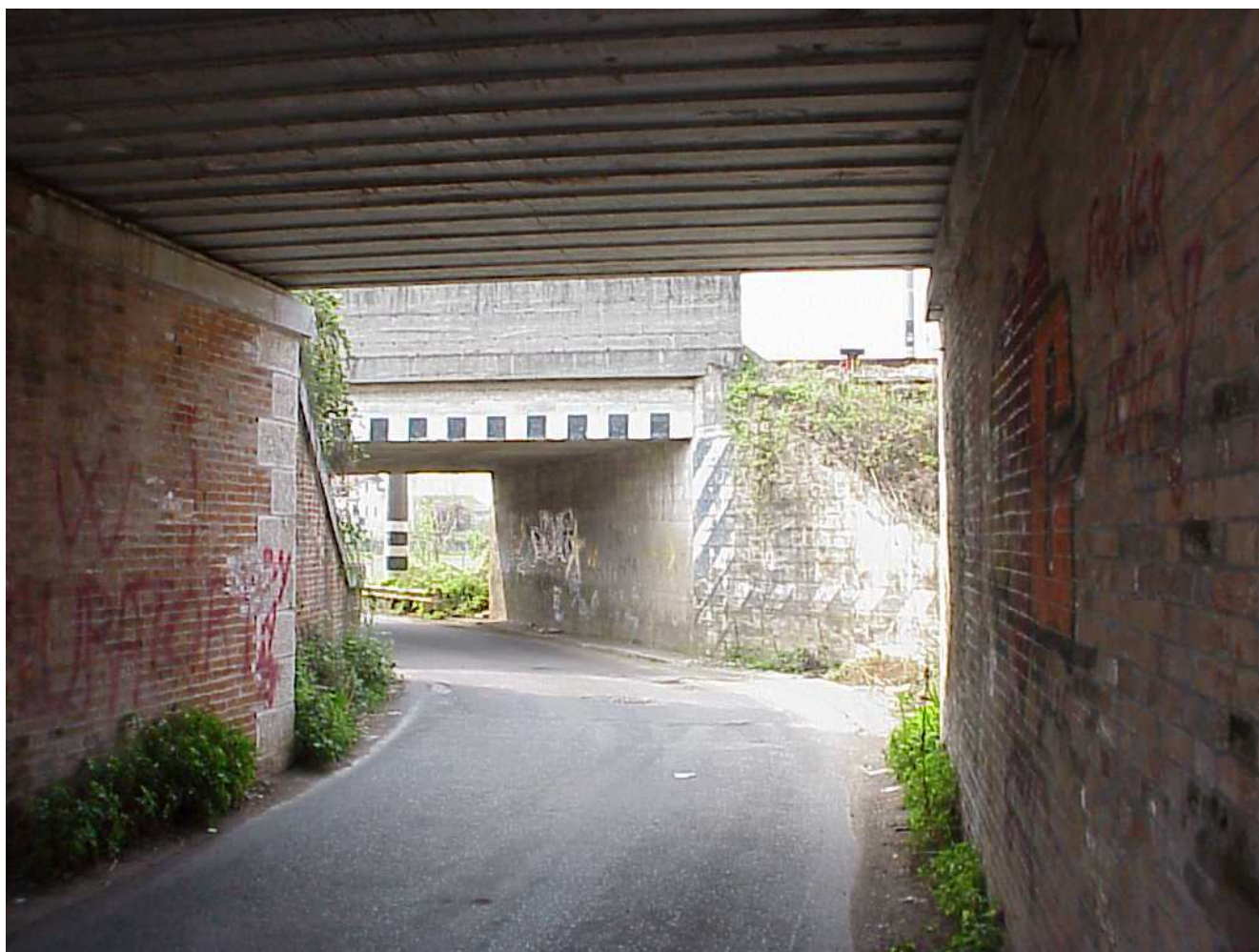
Figura 21 – Manufatti che attualmente consentono l'attraversamento di Via Carnia – Punto di presa posto a Sud nelle immediate vicinanze dell'imbocco dell'attraversamento della linea Merci per il Quadrante Europa
