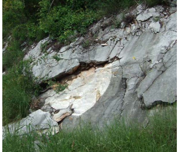
Particolare della scarpata con modesti crolli lapidei
