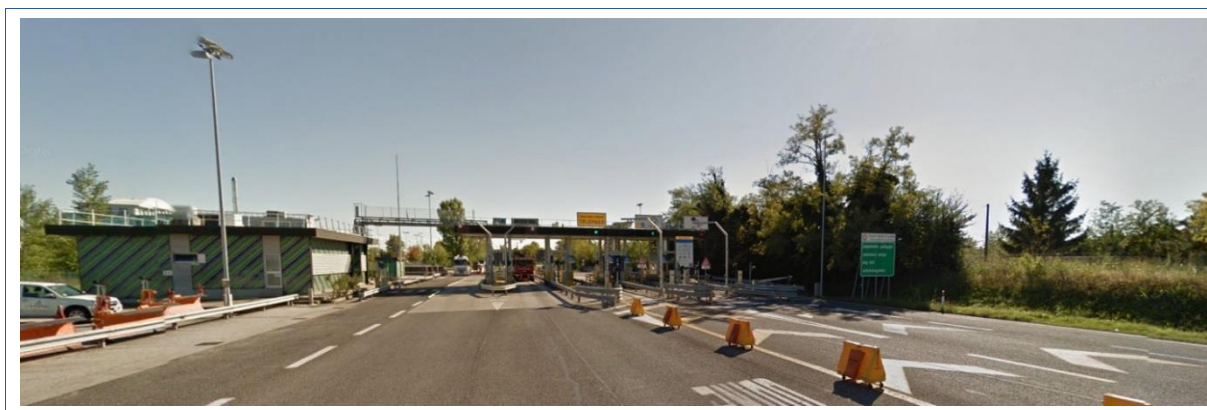
Foto 9 – Vista sulle porte di esazione in uscita dall'Autostrada.
