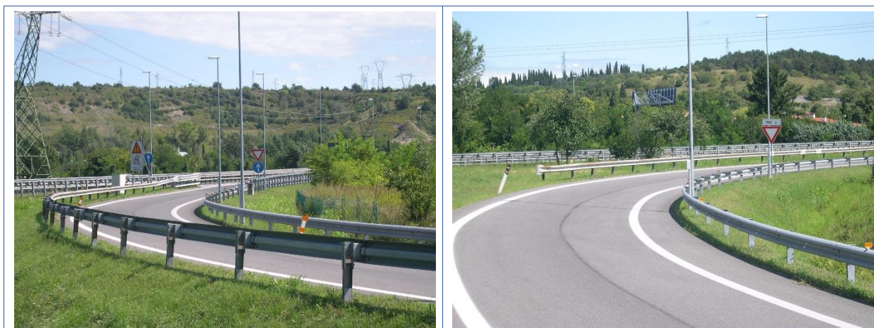
Foto 3 – Foto 4 - Pista accelerazione verso TS; lato dx in ampliamento
