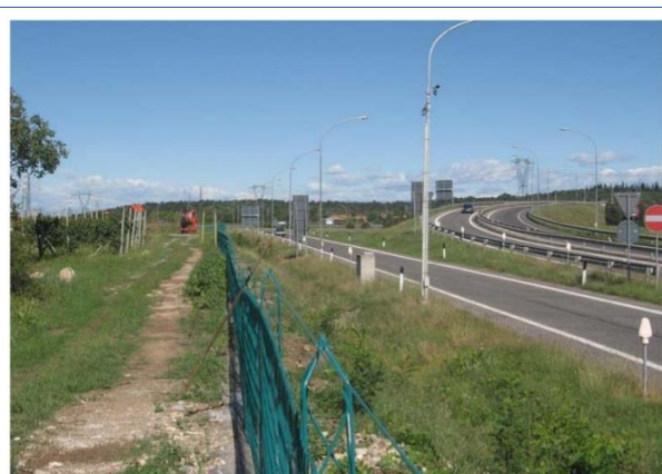
Foto 8 – Vista verso nord, recinzione est della pista di decelerazione da VE-UD.
