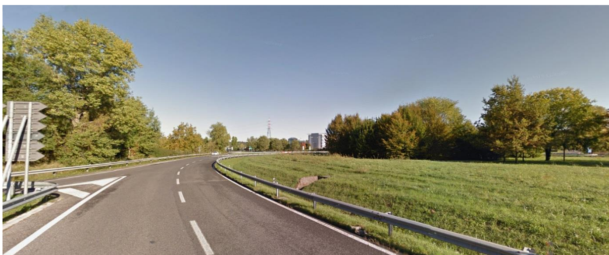
Fig. 35 – A dx, vegetazione interna della rotonda dopo l'uscita dal casello (al centro, sullo sfondo).
