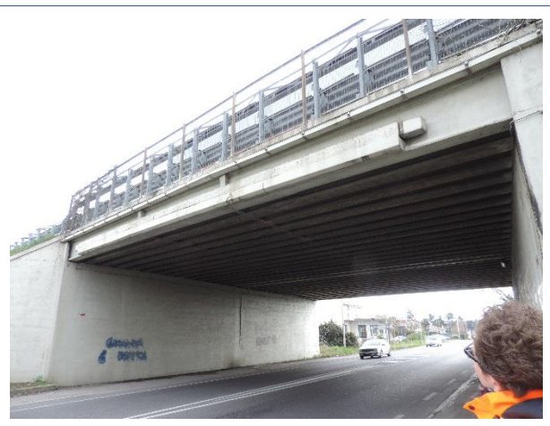
Foto 12 – Dettaglio cavalcavia SS.305
