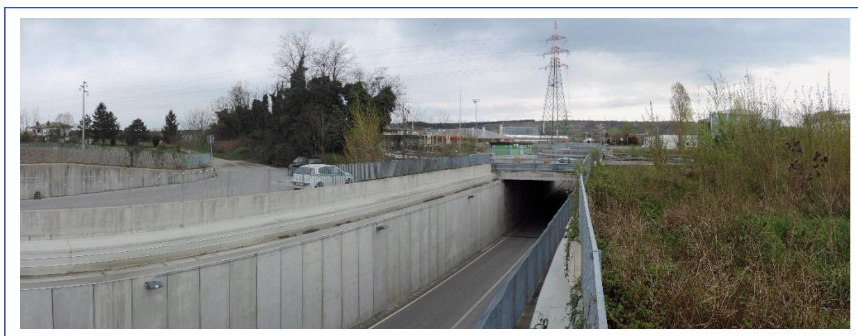
Foto 15 – Sottopasso V. Micca, in uscita verso Fogliano. A sinistra boscaglia di robinia cresciuta a ridosso della cabina Enel da delocalizzare.
