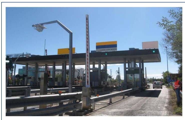
Foto 10 – Vista da sud cavalcavia SS.305
