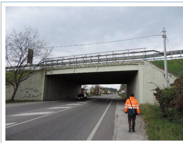
Foto 11 – Vista da sud cavalcavia SS.305
