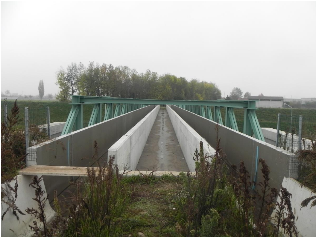
Figura 4.3 – Lato nord. Attraversamento costituito da due canalette irrigue e un passaggio pedonale. In fondo un piccolo bosco
