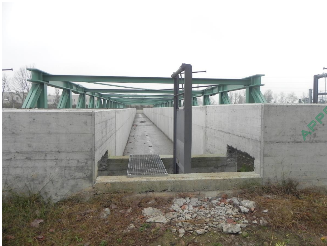
Figura 4.4 – Lato sud. Accesso al passaggio pedonale per mezzo di grata metallica
