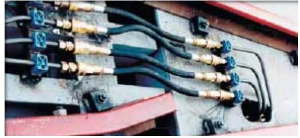
sistema tipo di scambio per la gestione logistica dei vagoni in cantiere
