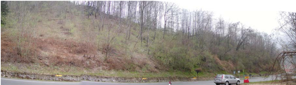
Foto 6.1 - Zona dell'imbocco della galleria lato Coggiola
