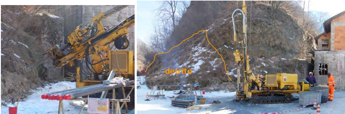
Foto 6.5– Postazioni dei sondaggi SG5 e SG6 allineati all'imbocco della galleria
