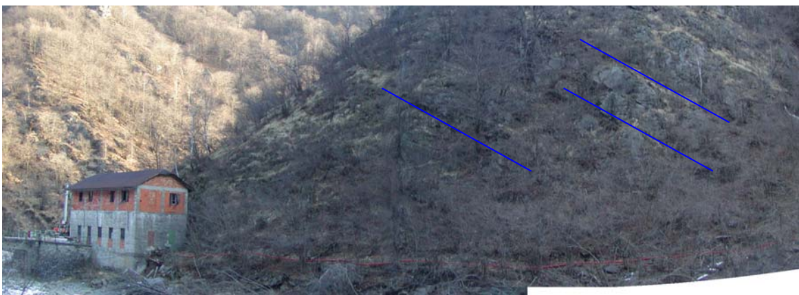
Foto 6.2 Imbocco della galleria lato Centrale del Piancone (uscita fresa)
