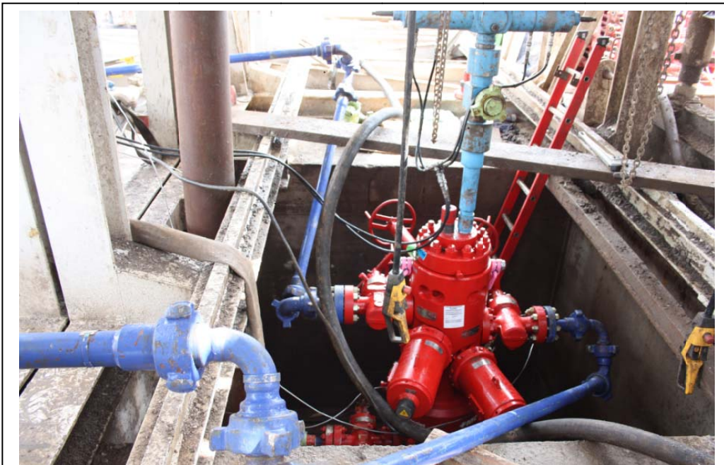
Figura 5.29. Approntamento della testa pozzo.
