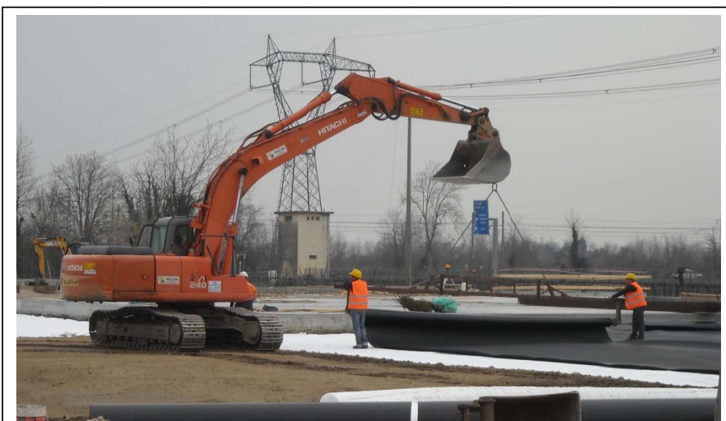
Figura 5.8. stesura geomembrana poi saldata a caldo (Area pozzo Cascina Daga1 dir – Apennine Energy S.p.A.)
