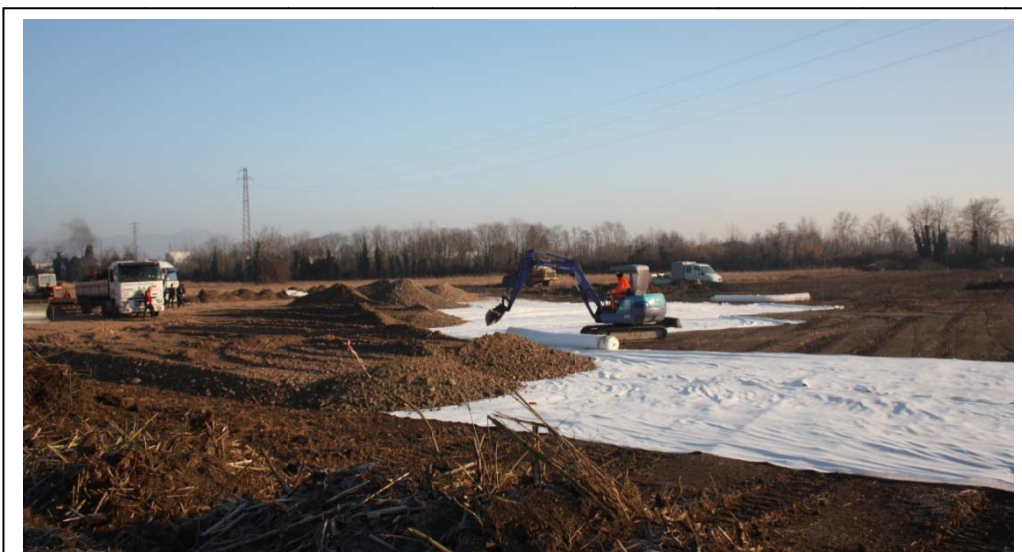
Figura 5.7. Preparazione area posteggio (Area pozzo Cascina Daga1 dir – Apennine Energy S.p.A.)
