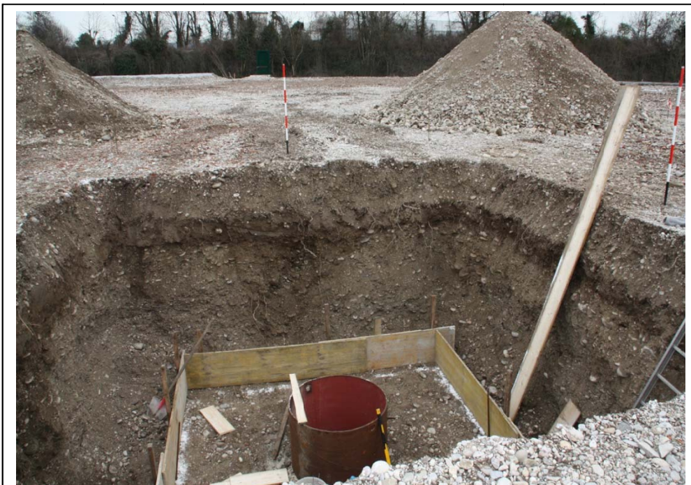
Figura 5.12. Realizzazione cantina (Area pozzo Sant'Andrea 01 dirST1 – Apennine Energy S.p.A.)
