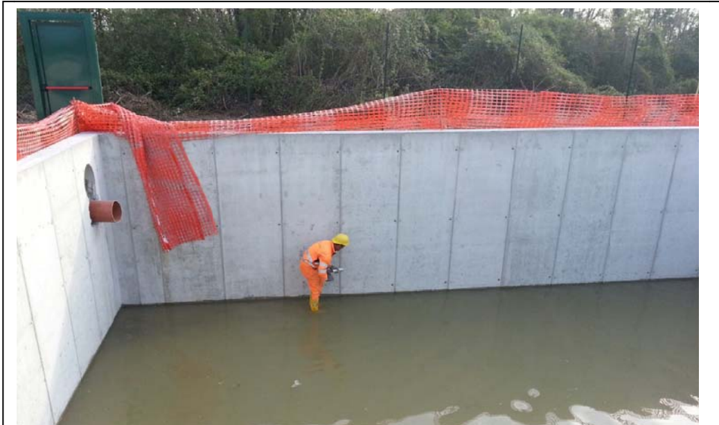
Figura 5.11. vasca raccolta acque meteoriche nel cantiere (Area pozzo Cascina Daga 1 dir – Apennine Energy S.p.A.)
