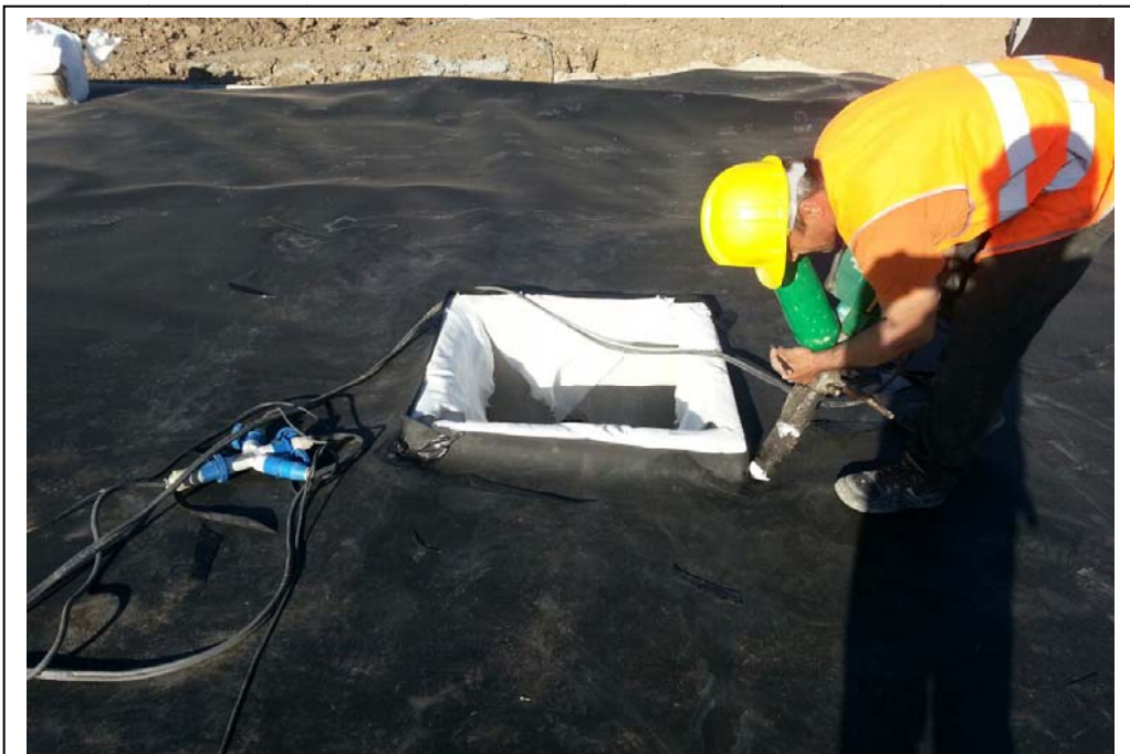
Figura 5.35.. Saldatura a caldo dell'HDPE
