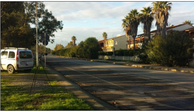
Figura 11 – Vista del Punto 01
