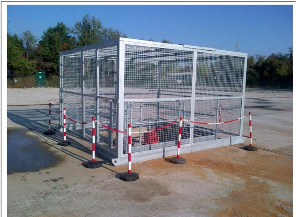
**Figura 15. Gabbia metallica per protezione testa pozzo**
