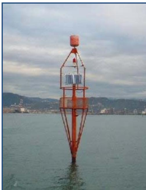
Questa tipologia di segnalamento, pur non essendo di tipo monolitico e solidale con il fondo, ha un'elevata stabilità ed un limitato scostamento rispetto al vincolo di fondale. Il
