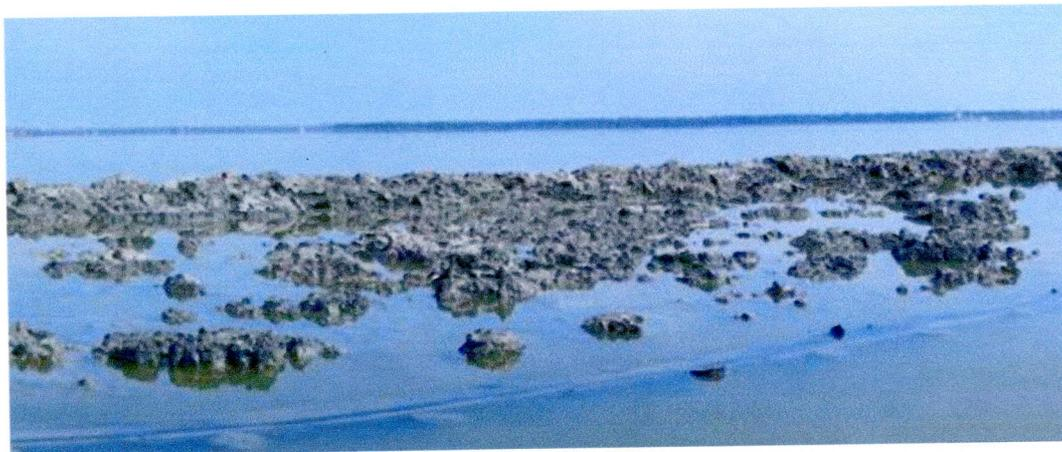
**Figura 2.** Dozzo Pugnolino nel luglio 2013: la palificata è sommersa ed il terrapieno è ormai completamente eroso.
