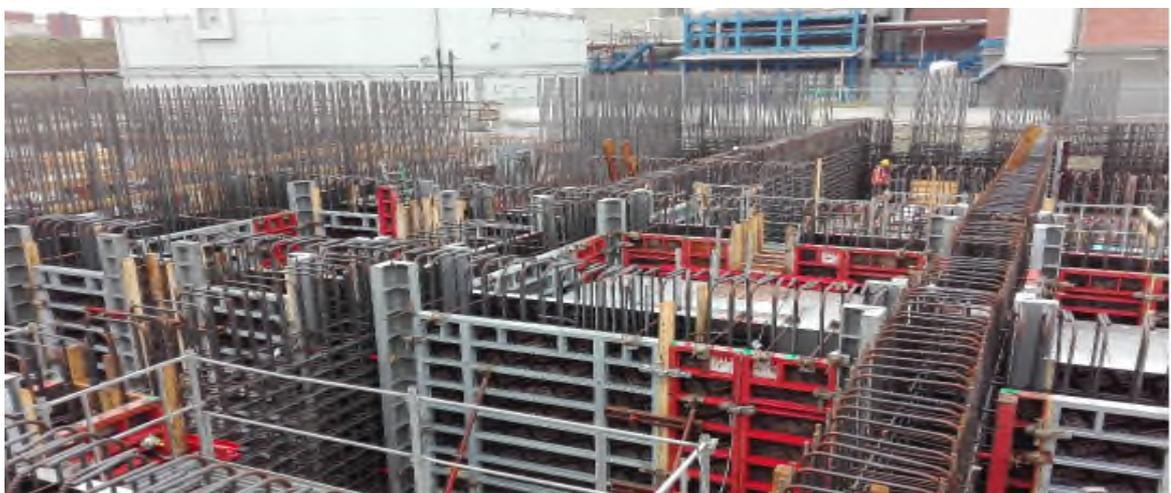
Figura 2-3 – Vista d'insieme e particolare della cassetatura delle pareti del deposito D3
