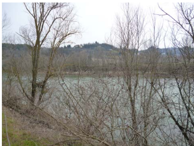
Figura 3. Il popolamento forestale che caratterizza la sponda sinistra nei pressi della realizzazione della traversa di derivazione
