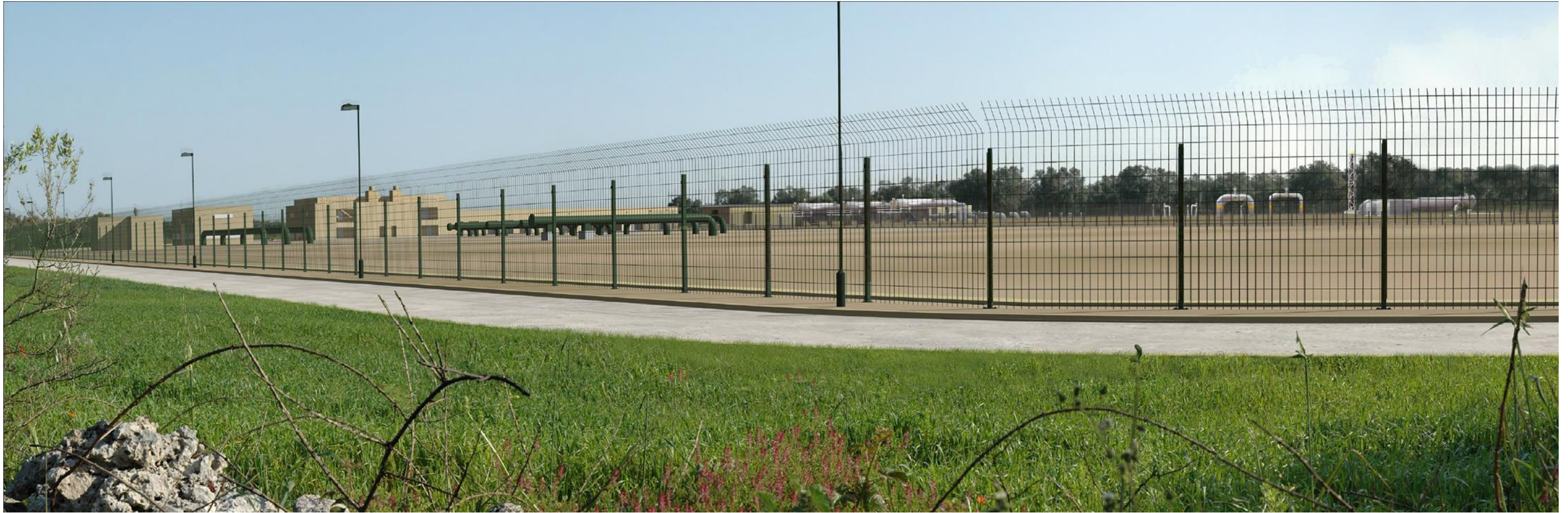
Fig 1/ C - Met. Interconnessione TAP, DN 1400 (56"), DP 75 bar. Impianto n.1 in Comune di Melendugno
