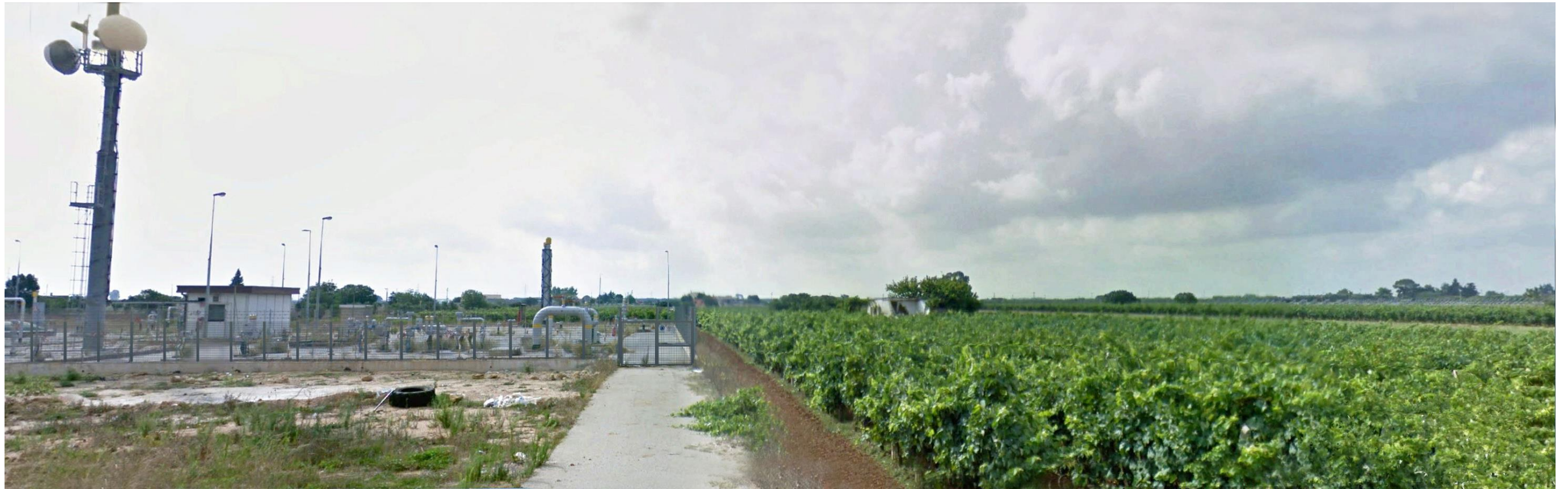
Fig 1/ M - Met. Interconnessione TAP, DN 1400 (56"), DP 75 bar. Impianto n.1 in Comune di Brindisi
