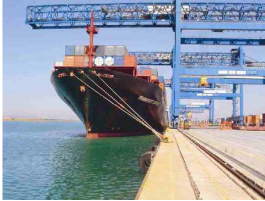
Fig. 7.1.2 – Gru da banchina.
