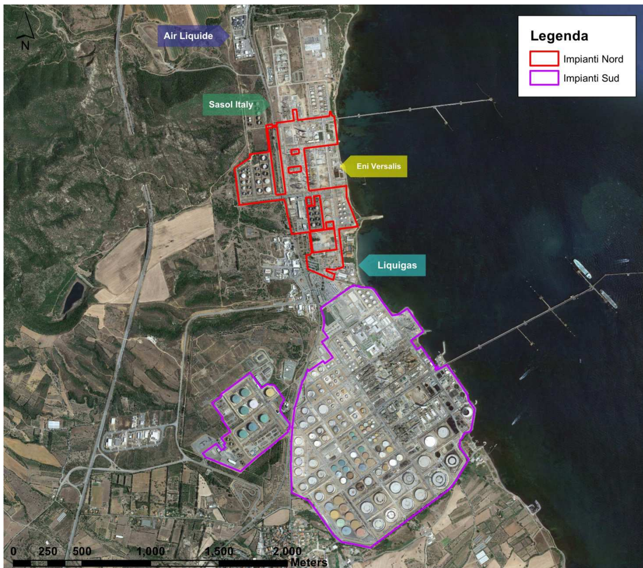
Figura 1 – Inquadramento territoriale dello Stabilimento Sarlux e delle principali installazioni impiantistiche presenti nel comprensorio industriale
