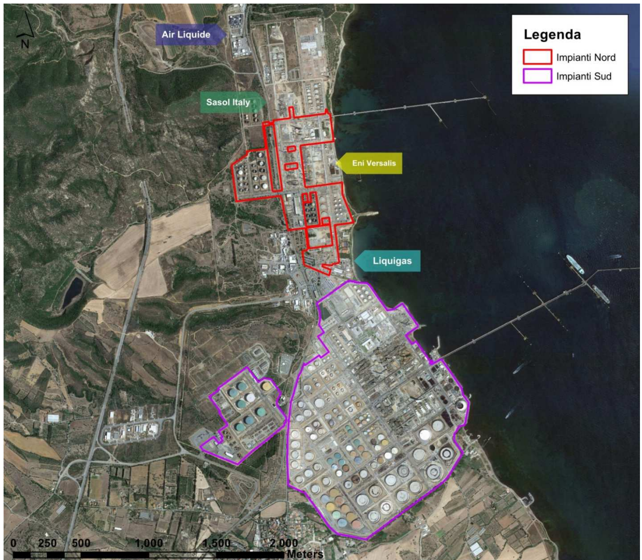
Figura 1 – Inquadramento territoriale dello Stabilimento Sarlux e delle principali installazioni impiantistiche presenti nel comprensorio industriale
