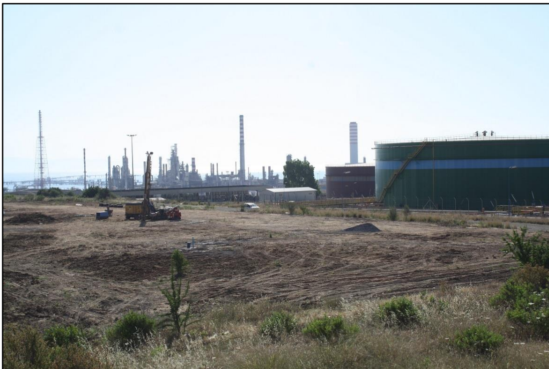
Figura 50 - L'area su cui saranno realizzati i nuovi serbatoi vista da ovest
