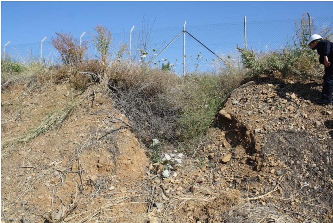
Figura 43 – Solco di ruscellamento concentrato nella parte orientale della scarpata artificiale del perimetro settentrionale dell'area di progetto
