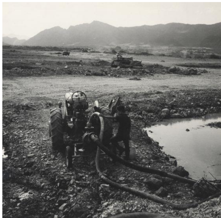
Figura 16 - Lavori di bonifica per la realizzazione della raffineria di Sarroch (Fonte: archivio storico Sarlux, anno 1963)
