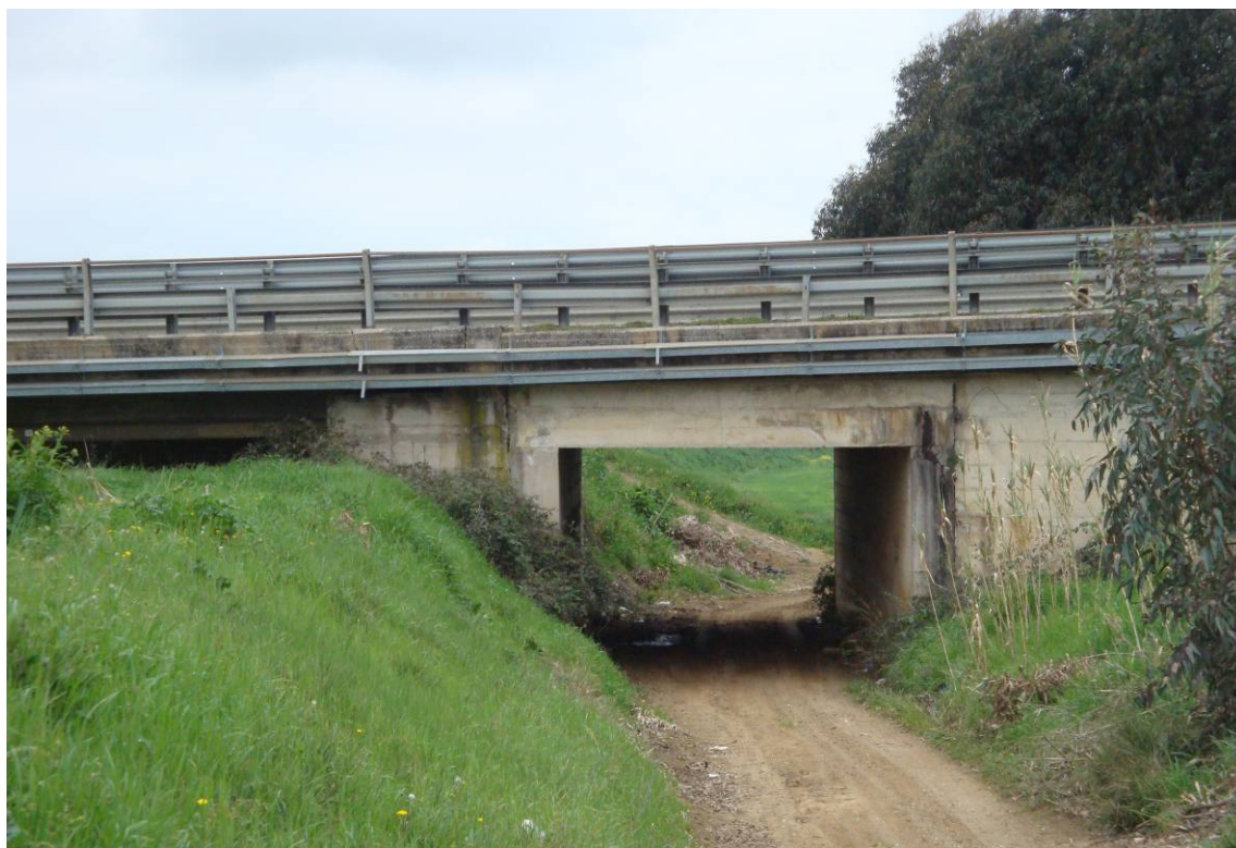
Foto 3 – Vista laterale del sottovia nord
