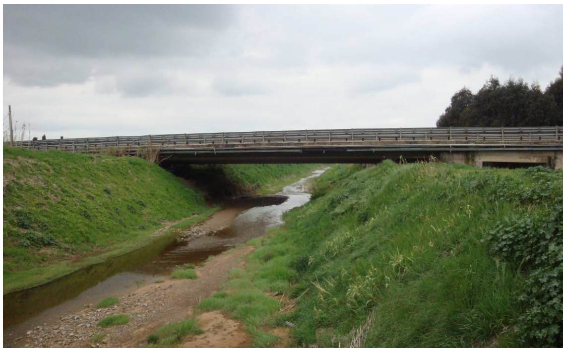
Foto 1 – Vista laterale da monte
