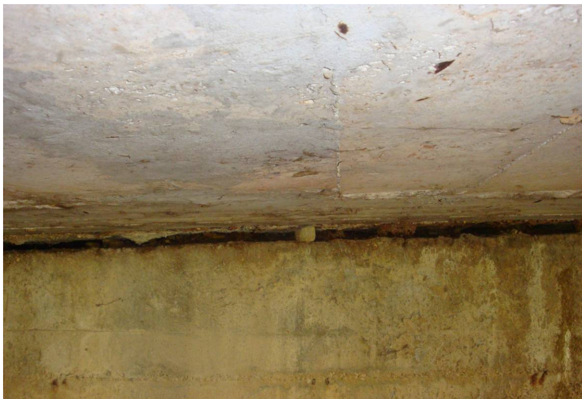
Foto 7 – Particolare appoggio dell'impalcato sulla spalla
