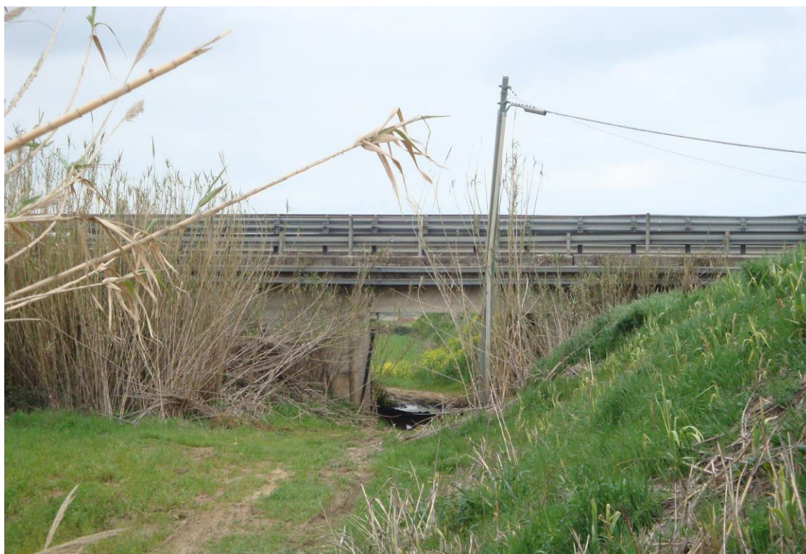
Foto 4 – Vista laterale del sottovia nord
