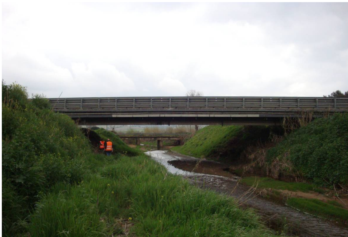
Foto 2 – Vista laterale da valle
