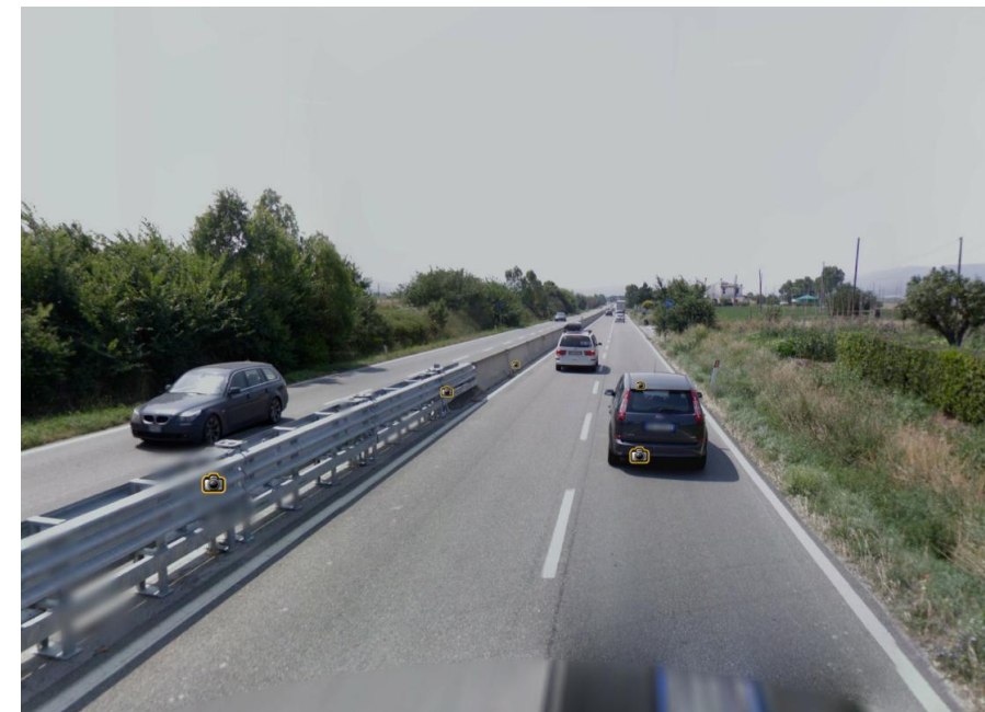
Passaggio da barriera di sicurezza metallica a NJ in spartitraffico, dopo Rispescia
