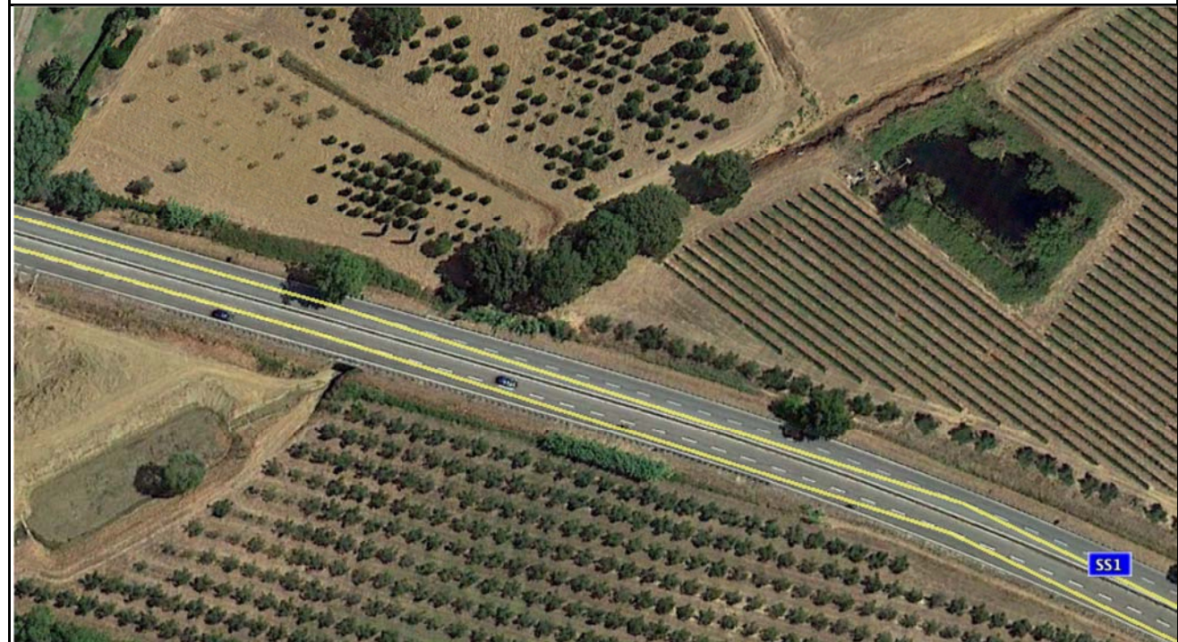
Fosso Valle Giardino (progressiva 6+300 ca)
