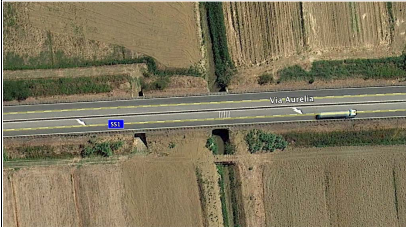
Fosso Migliarino (progressiva 5+000 ca)
