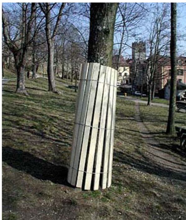
Immagine: protezione del fusto di un albero da tutelare durante i lavori
