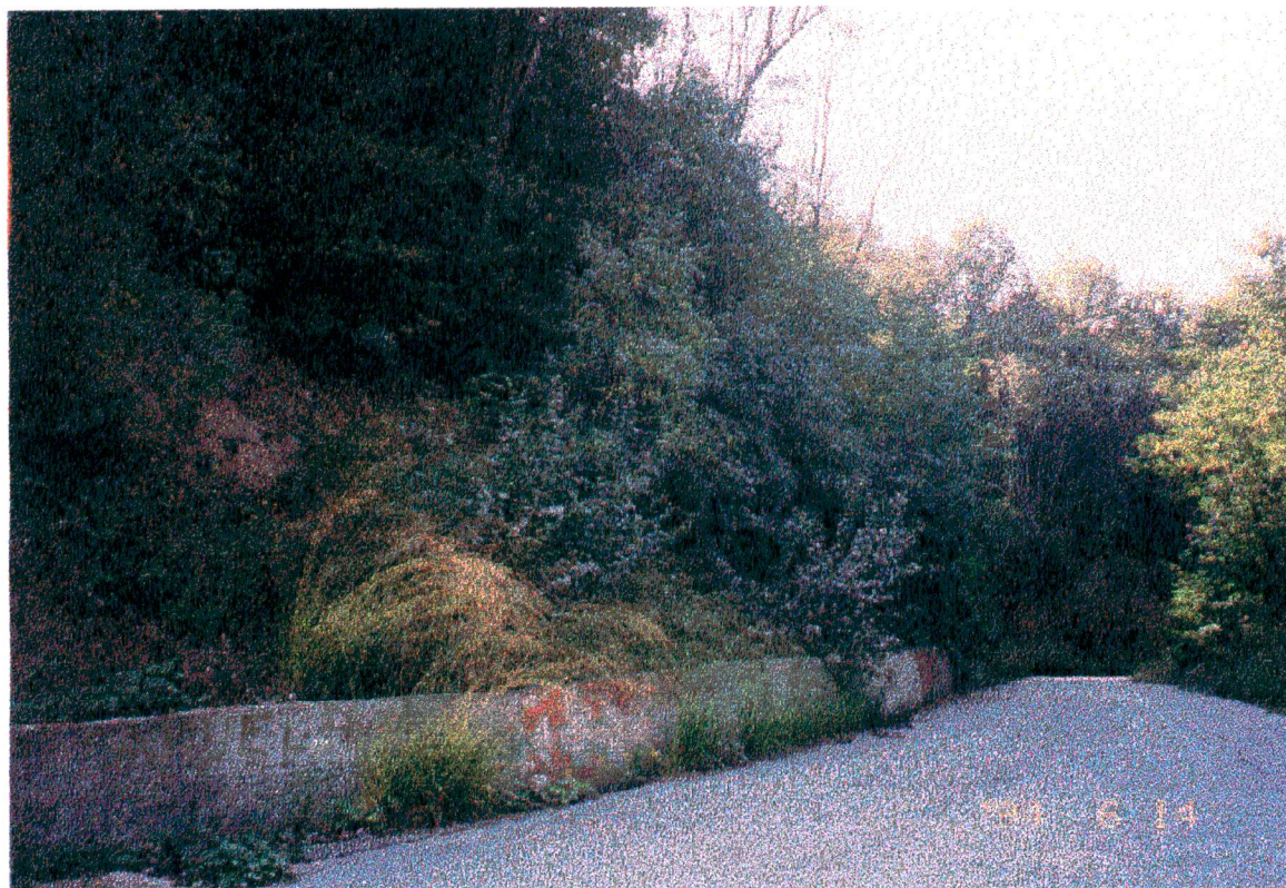
Foto n.4: Strada panoramica verso il M.te Terla- Punto di attacco della nuova strada.
