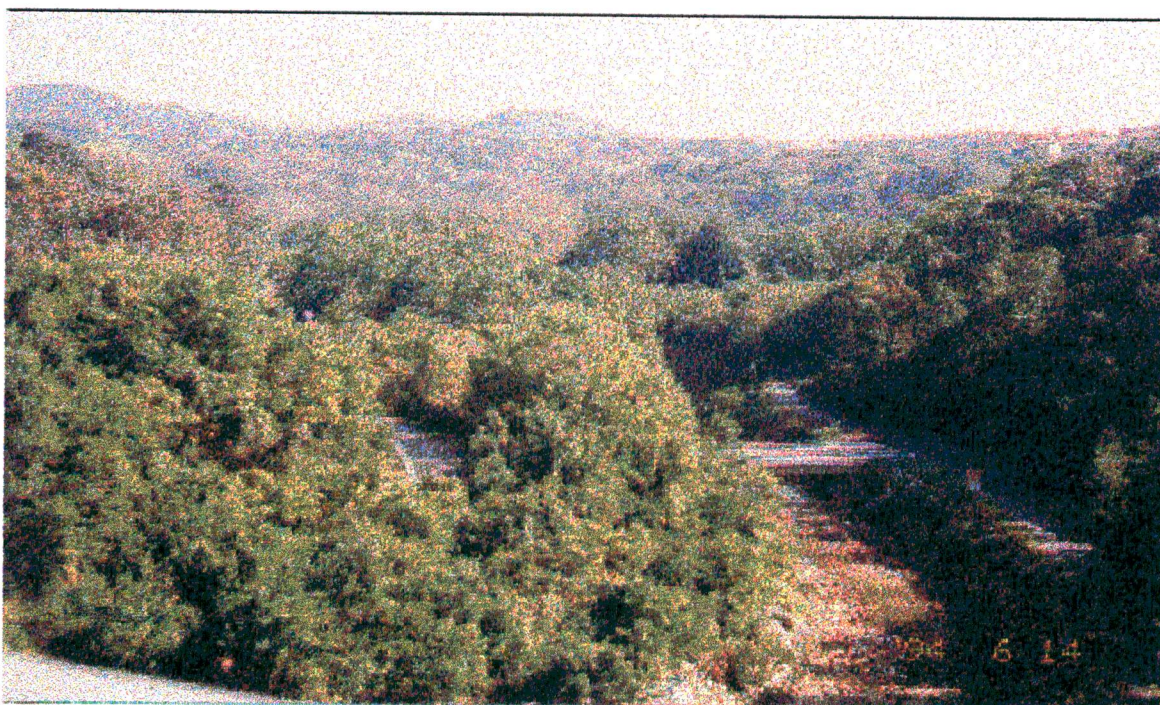
Foto n.2: Zona interessata dal nuovo impianto di npotabilizzazione
