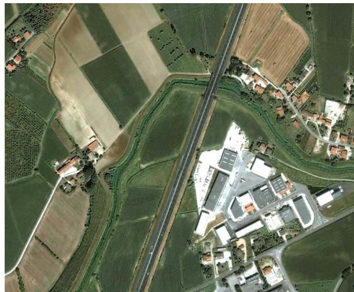
Panoramica da Google Earth
