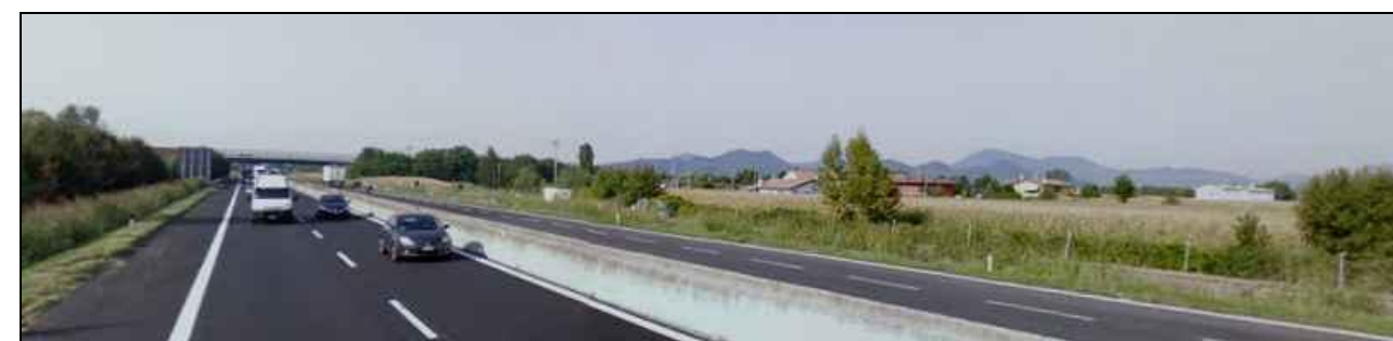
Foto 3.44 Maserà di Padova, edificato in linea su via Bolzani (prog. km 100+200)
