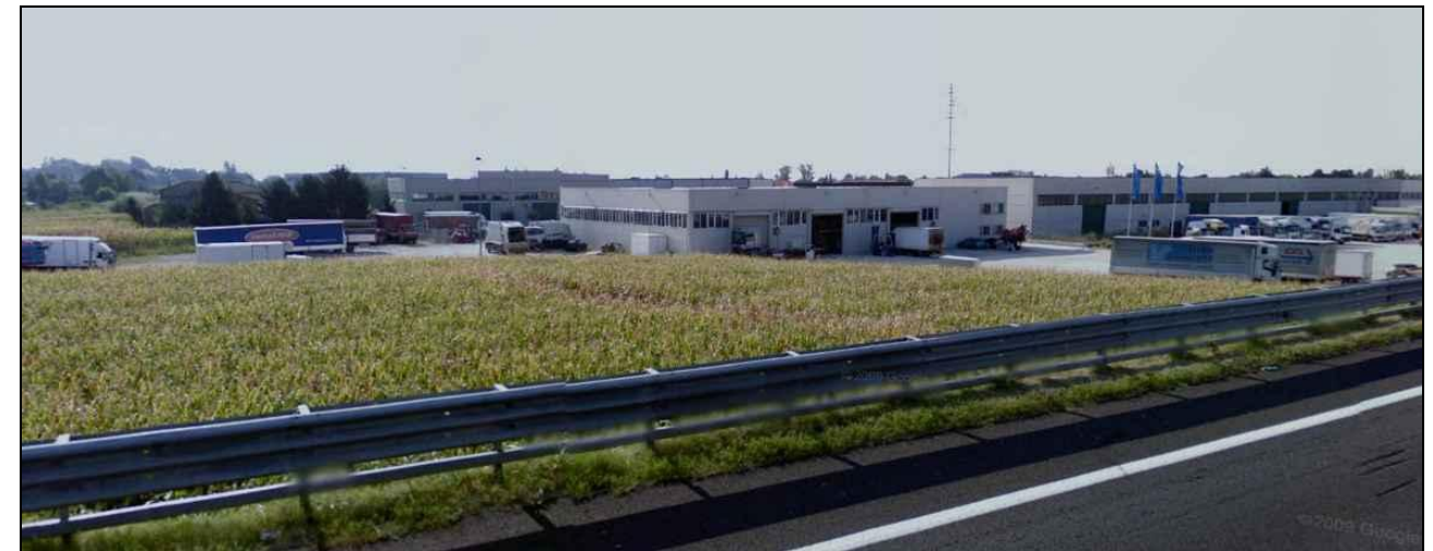
Foto 3.12 Area industriale di Pernumia vista da nord (prog. km 93+200)
