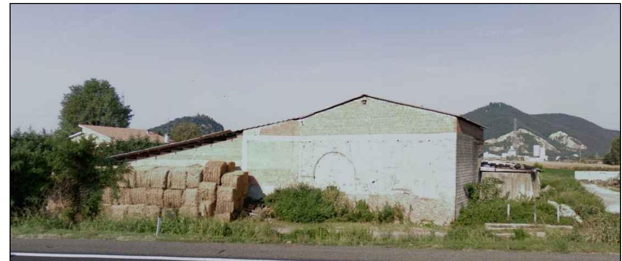
Foto 3.23 Monselice (km 89+500) edilizia povera e tipologie di edifici rurali recenti
