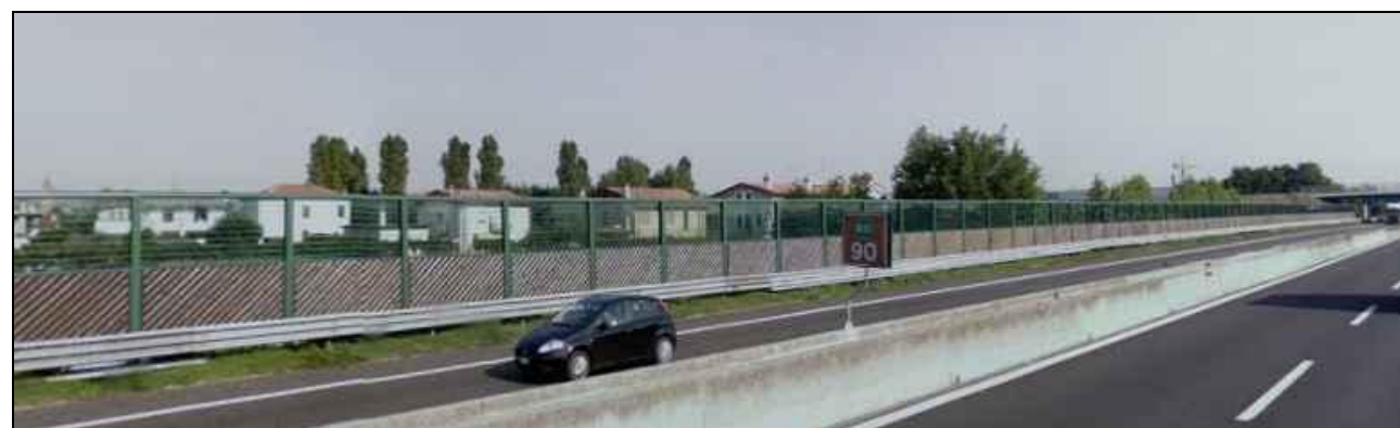
Foto 3.42 Ultime case di Terradura (Due Carrare) e la barriera acustica a protezioni delle emissioni sonore dell'A13
