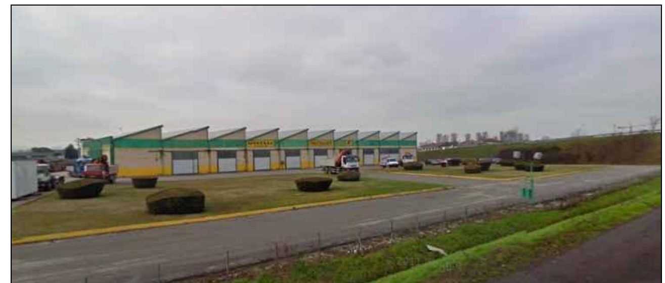
Foto 3.41 Dalla A13 verso ovest a sud della frazione di Due Carrare Terradura
