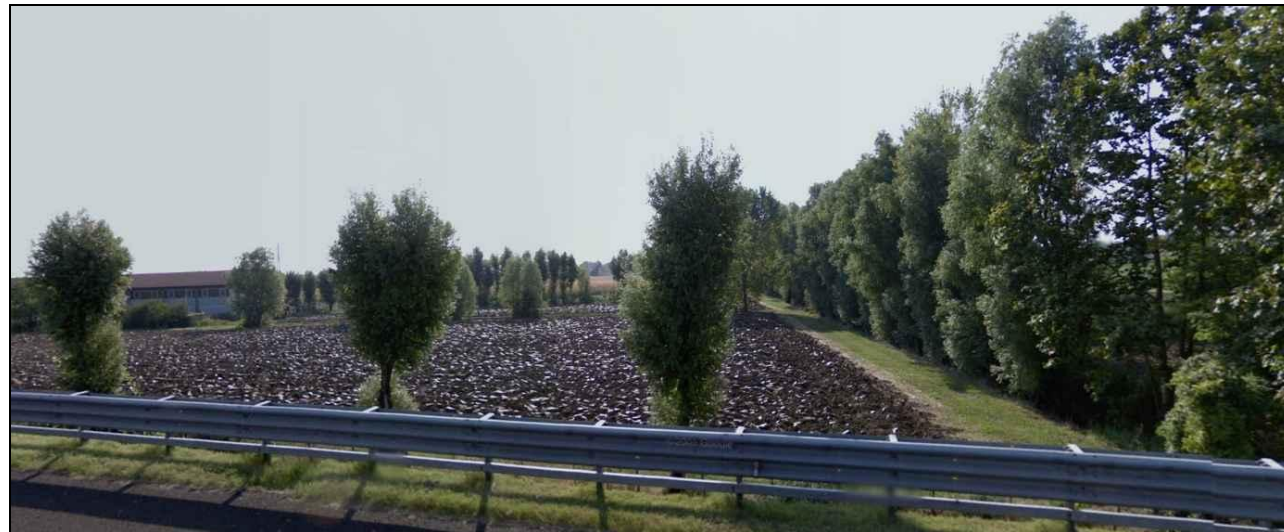
Foto 3.36 Due Carrare Fabbricati zootecnici e filari in fregio all'A13
