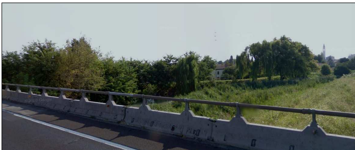
Foto 3.4 Canale Bagnarolo – Attraversamento A13 vista verso est
