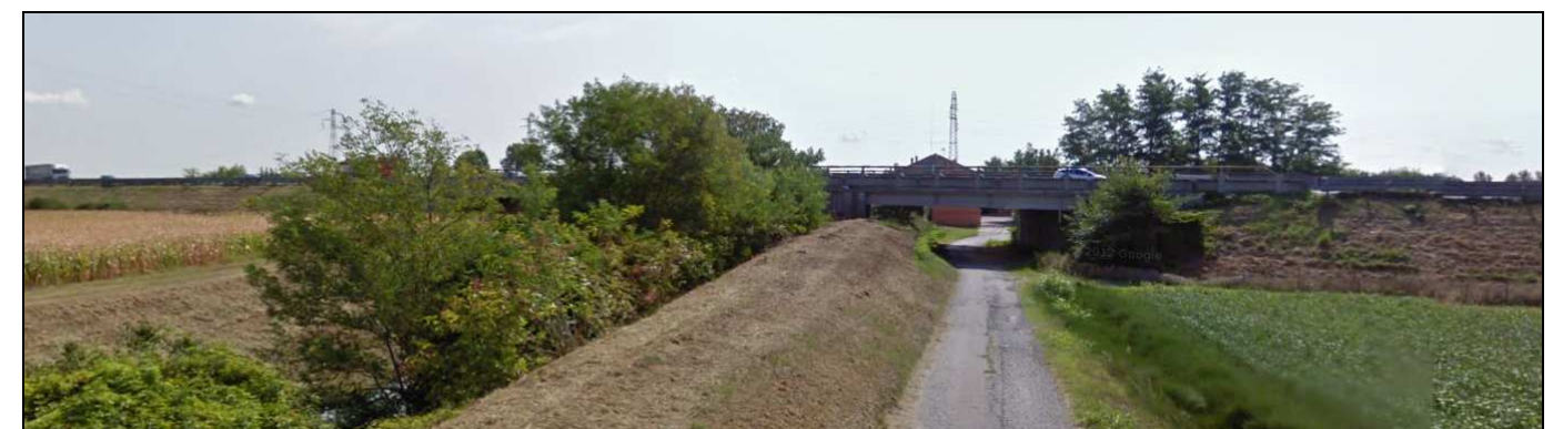
Foto 3.10 Fossa Paltana – Ponte dell'A13 visto da via Granze
