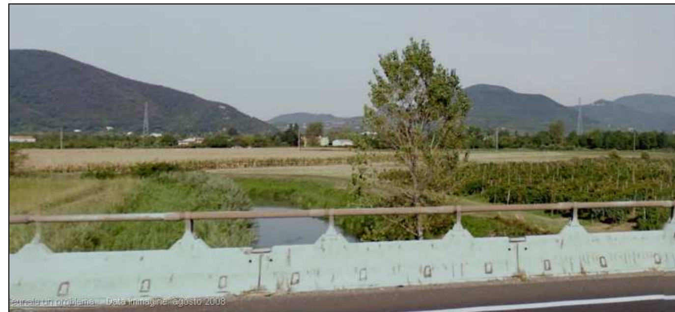
Foto 3.5 Canale Bagnarolo – Attraversamento A13 vista verso ovest
