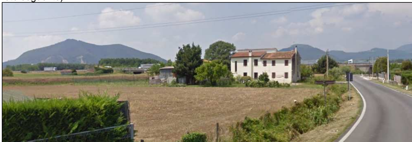
Foto 3.8 Canale Bisatto – Ponte dell'A13 visto da via Rivella
