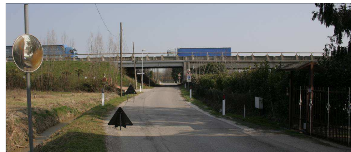
Foto 3.14 Ponte sul canale Biancolino – Via Saline vista verso est
