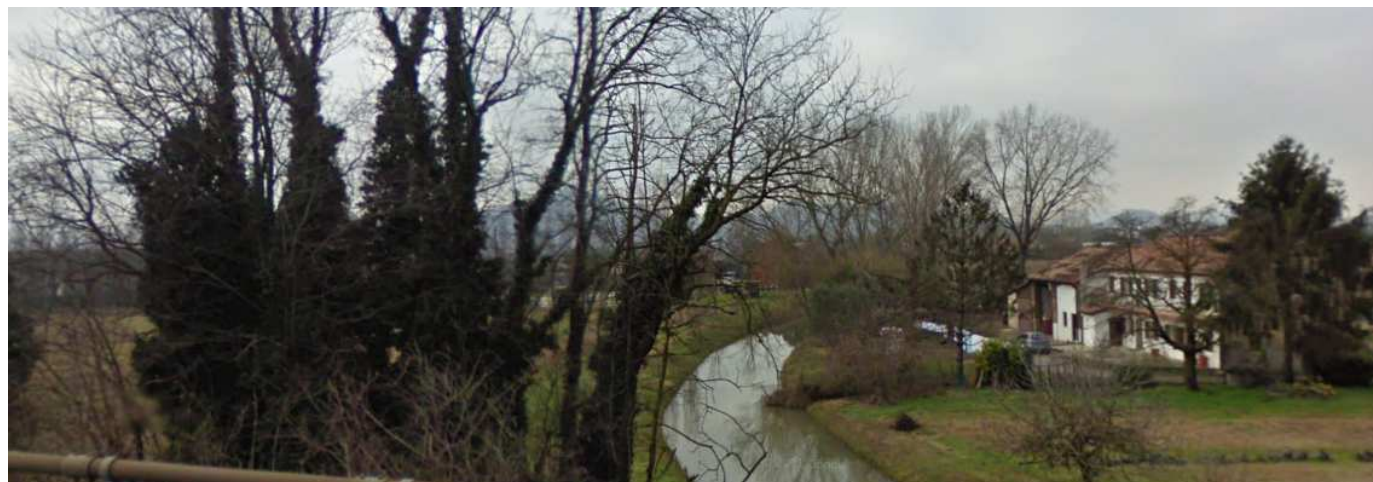
Foto 3.16 Ponte sul canale Biancolino dalla A13 verso ovest
