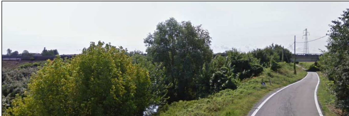
Foto 3.11 Canale Vigenzone – Ponte dell’A13 visto da via Palù inferiore
