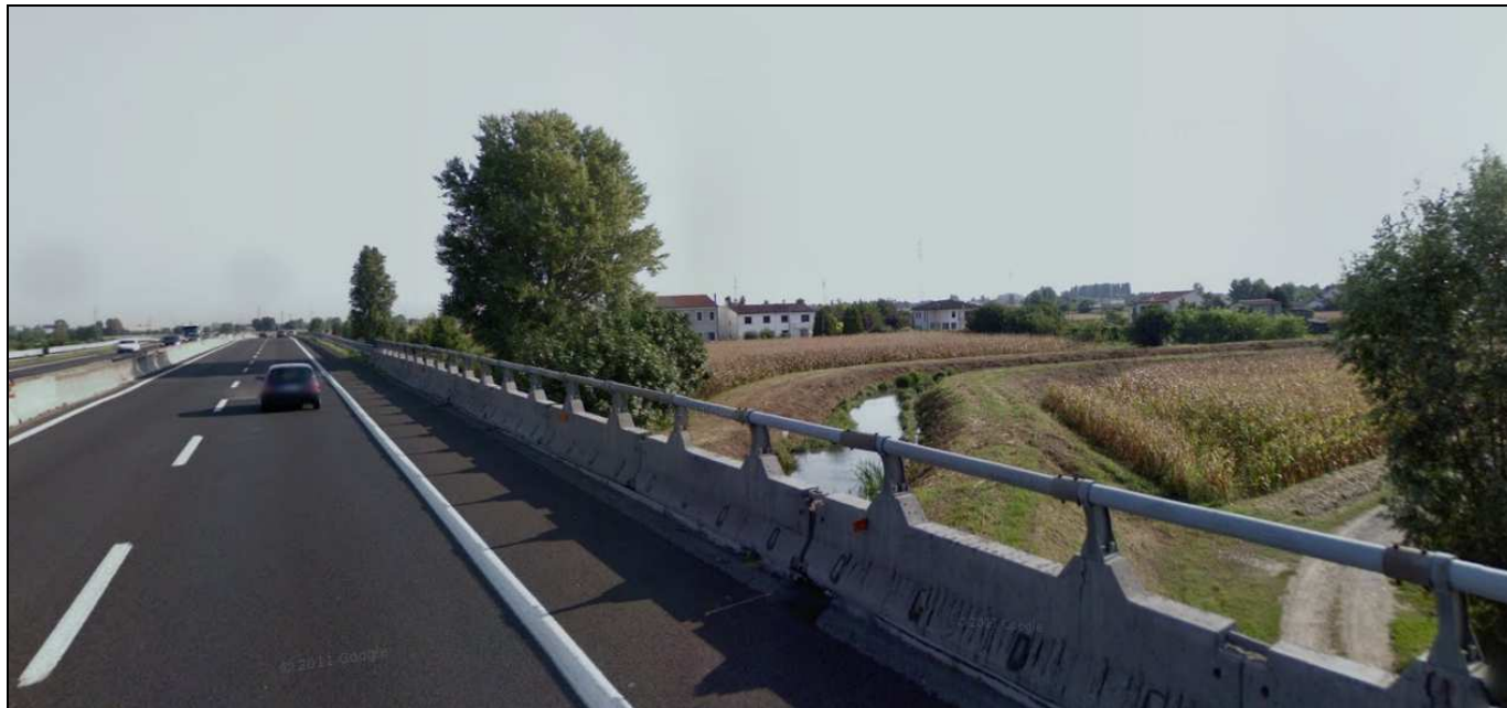
Foto 3.7 Canale Bisatto – Attraversamento A13 vista verso est
