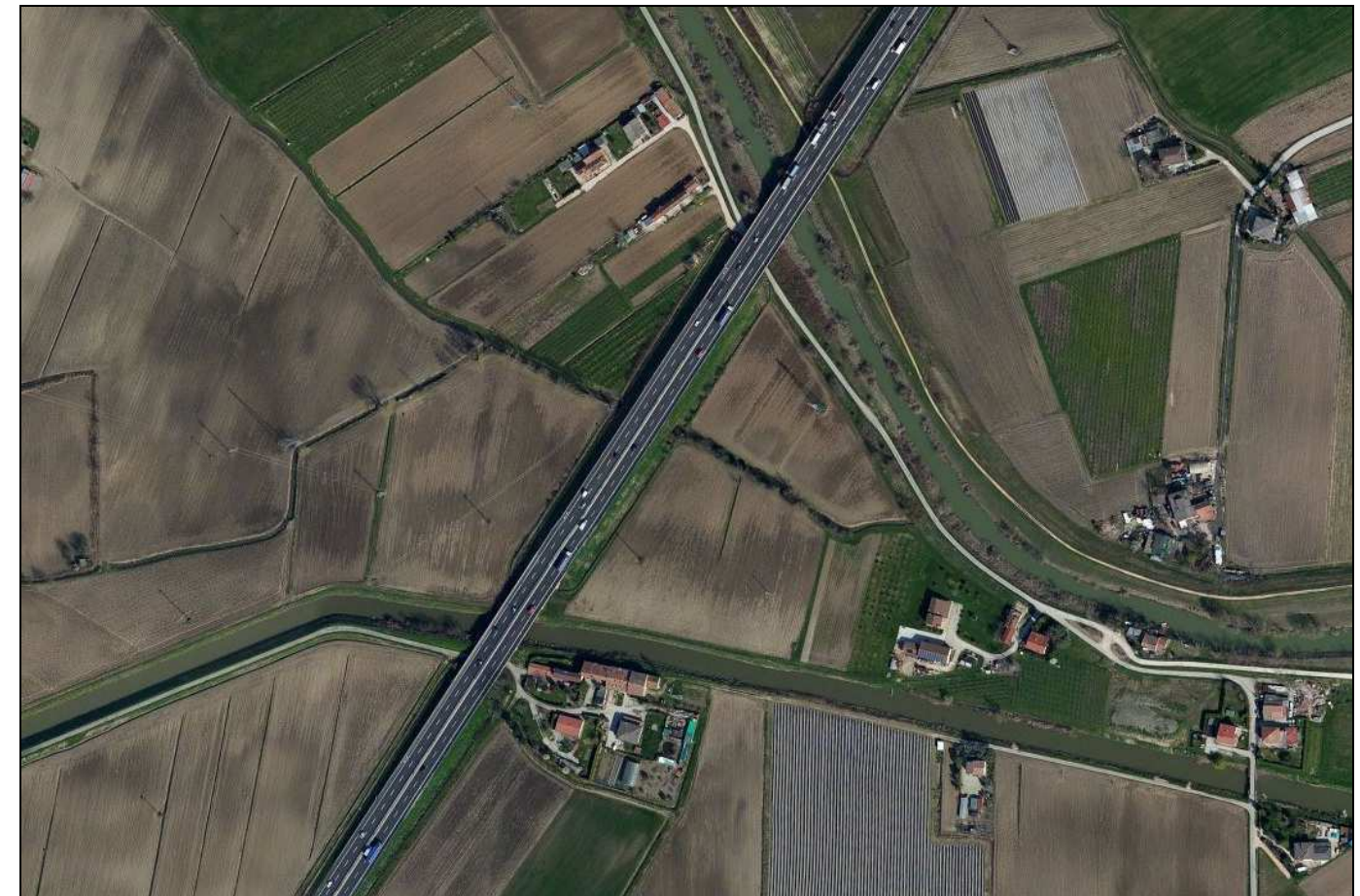
Figura 3.9 Fossa Paltana e Canale Vigenzone – ortofoto dell'attraversamento dell'A13
