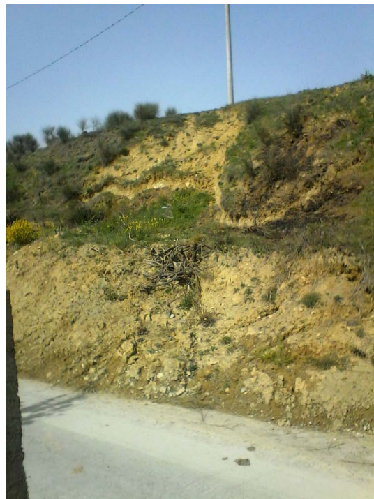
Foto 1 . Movimento franoso classificabile come scorrimento rotazionale (Intervento 1)
