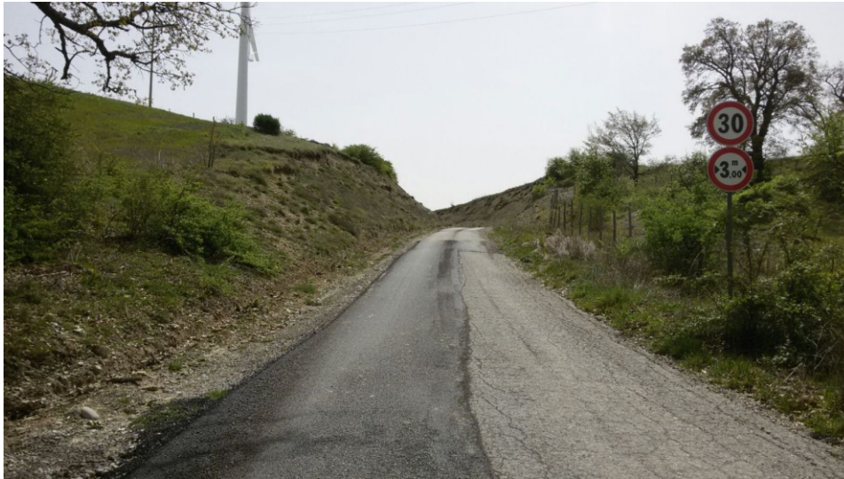
Foto 7 – Strada di accesso e percorso flowline
