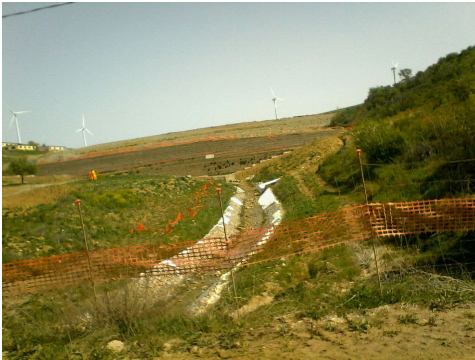
Foto 9 – Opera di sistemazione fosso di ruscellamento
