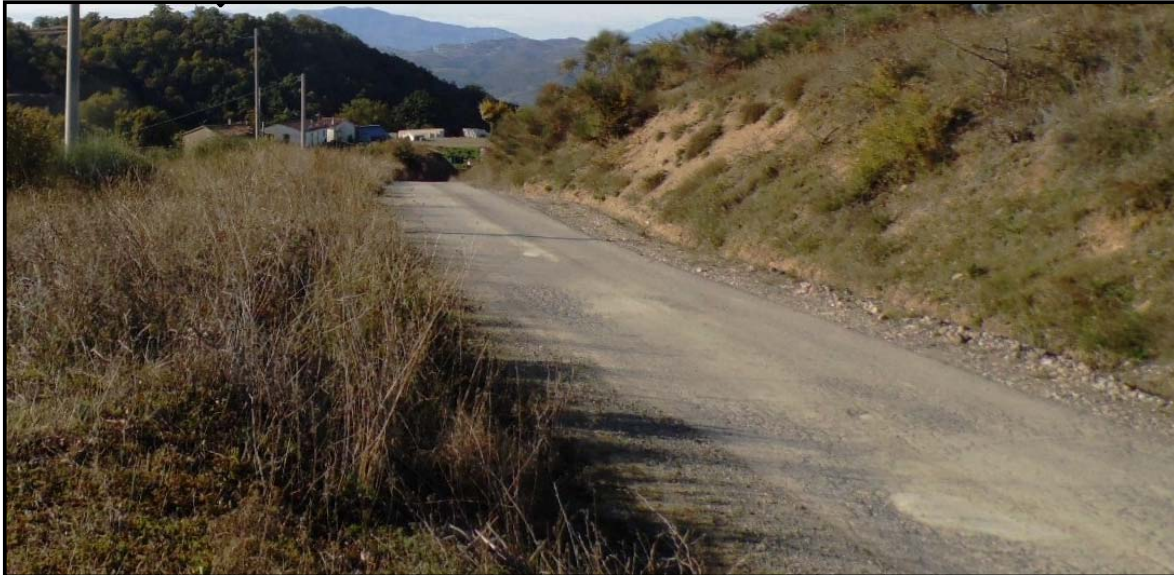
Fig. 5.3.4.1.a - Tratto della strada di accesso alla postazione di perforazione
