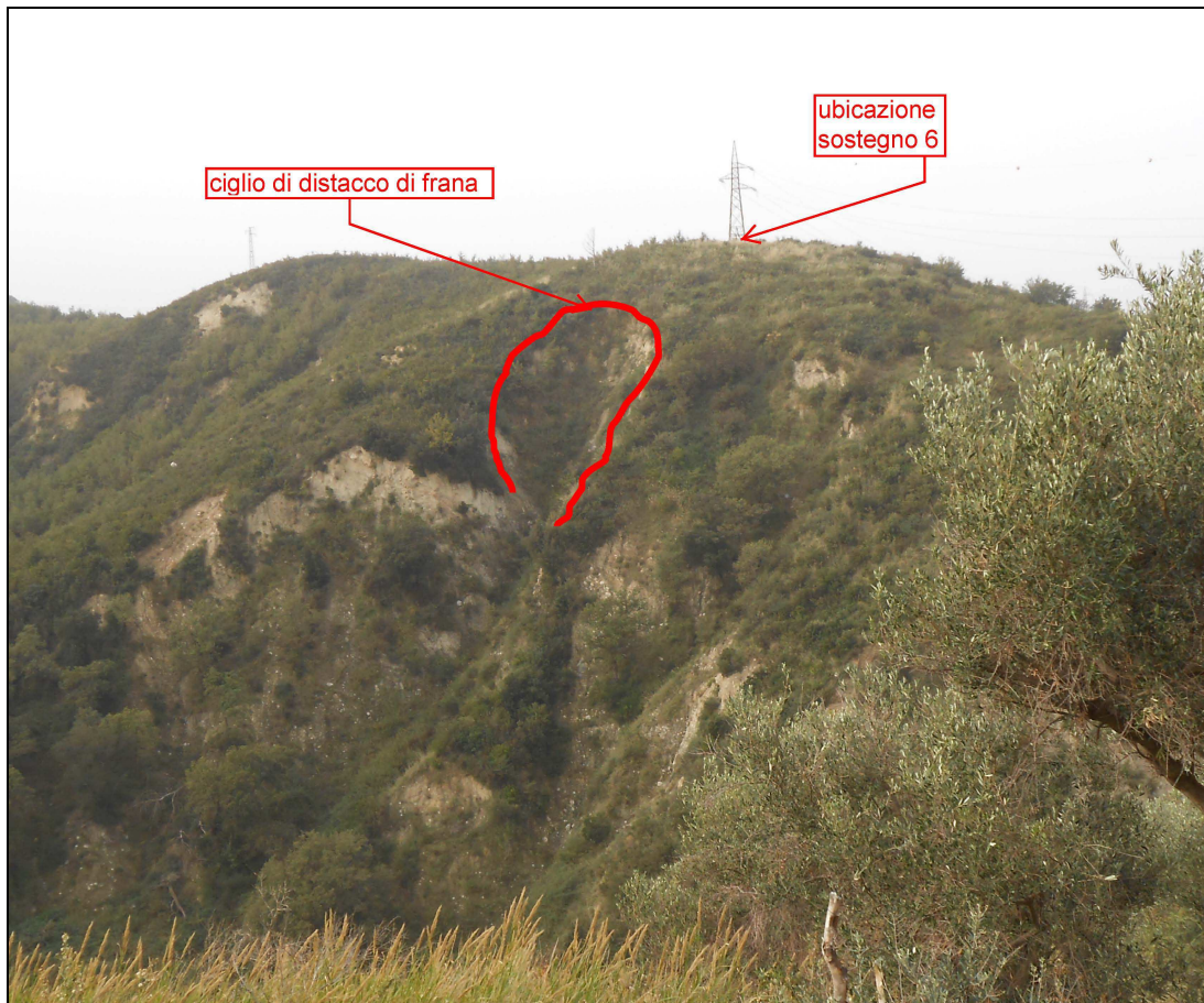
Foto 10: Ubicazione dei sostegni n. 6A e 6 B
