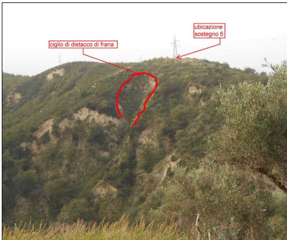
Foto 4: Ubicazione dei sostegni n. 6A e 6 B
