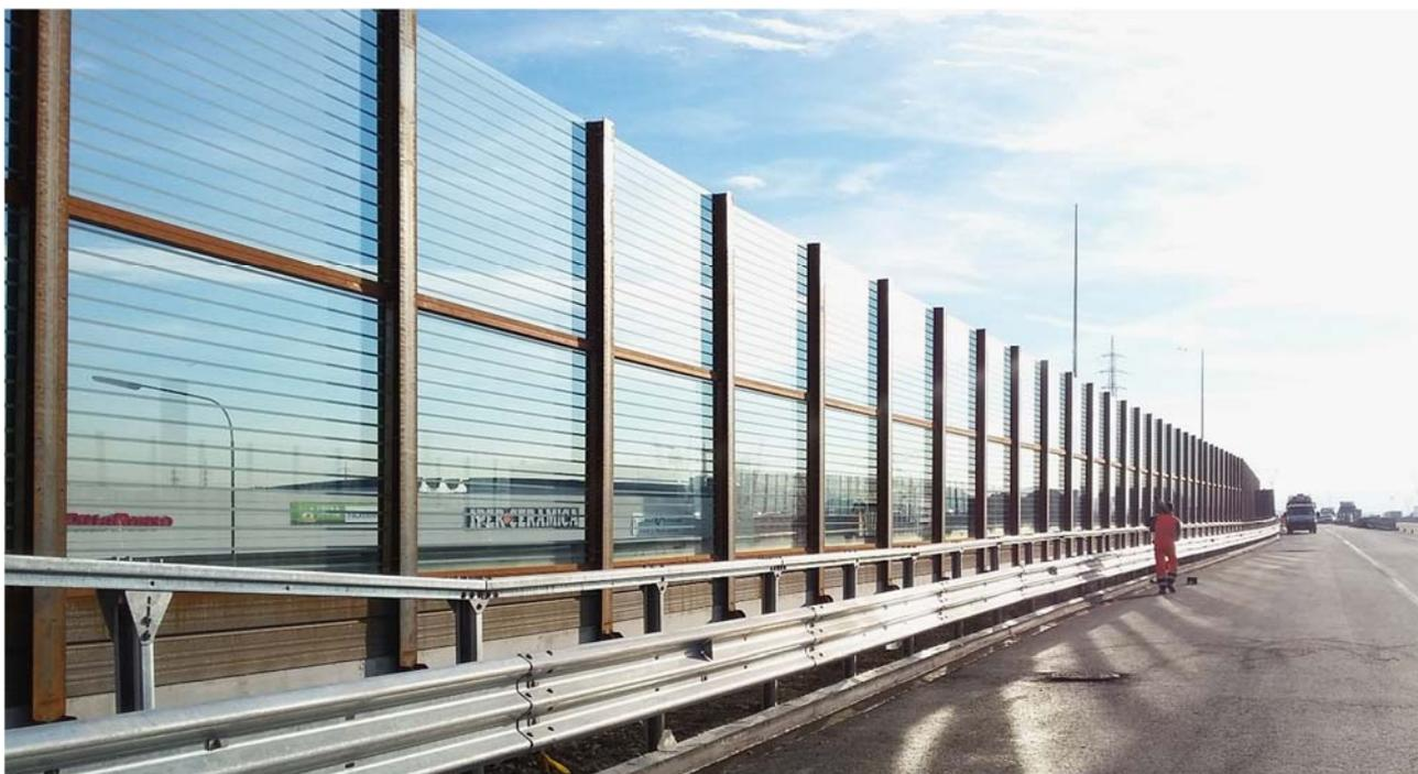
Figura 3.3.1 - Vista di una barriera Tipo B prevalentemente trasparente di 5 m di altezza, in fase di installazione lungo l'autostrada A1 Milano-Napoli in comune di Calenzano (FI)
