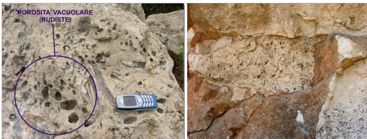
Figura 2.2 - Porosità "moldic" legata alla presenza di vacuoli dovuti alla dissoluzione delle Rudiste nei calcari del Cretaceo superiore della piattaforma Apula nelle Murge
