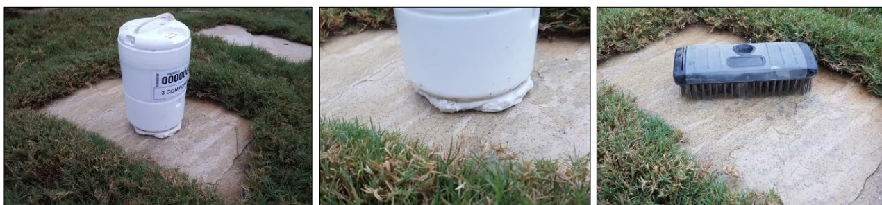
Figura 3.5 - Esempio di installazione di un geofono su roccia. A sinistra: geofono senza picchi fissato alla roccia con stucco/intonaco di Parigi. Al centro: primo piano della base del geofono. A destra: la rimozione dello stucco/intonaco-di-Parigi con acqua e spazzola restituisce la superficie alla sua condizione originale (fonte: Shell).
