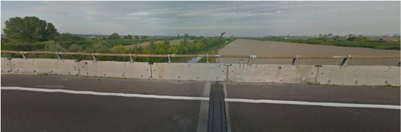
Figura 6: Fiume Reno in corrispondenza dell'attraversamento stradale
