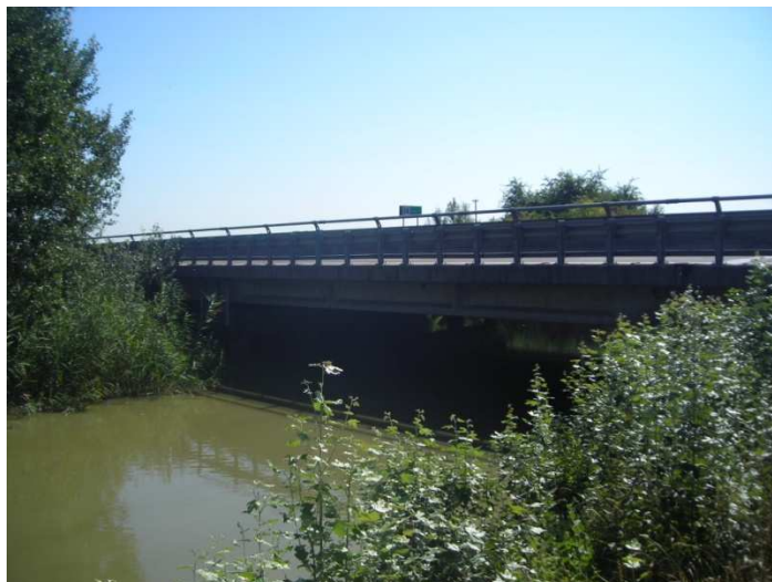
Figura 120: Scolo Calcarata in corrispondenza del viadotto autostradale (lato ovest)
