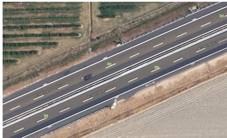
Figura 62: Autostrada A13 in corrispondenza della progressiva 32+967
