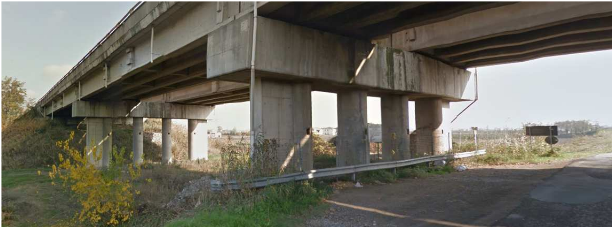
Figura 5: Ponte sul fiume Reno – Pile esistenti
