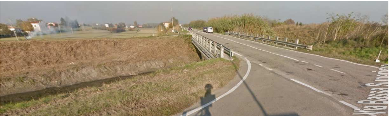
Figura 36: Confluenza del canale Diversivo in Savena Abbandonato
