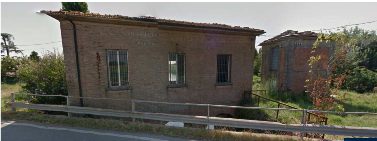
Figura 35: Manufatto di regolazione sul nodo col canale Navile
