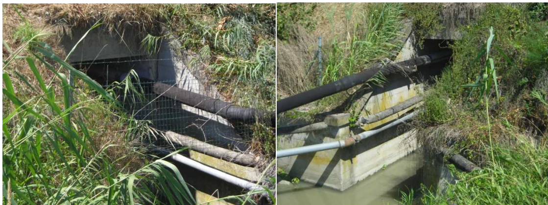
Figura 96: Scolo San Prospero in corrispondenza del tombino autostradale – lato est ed ovest
