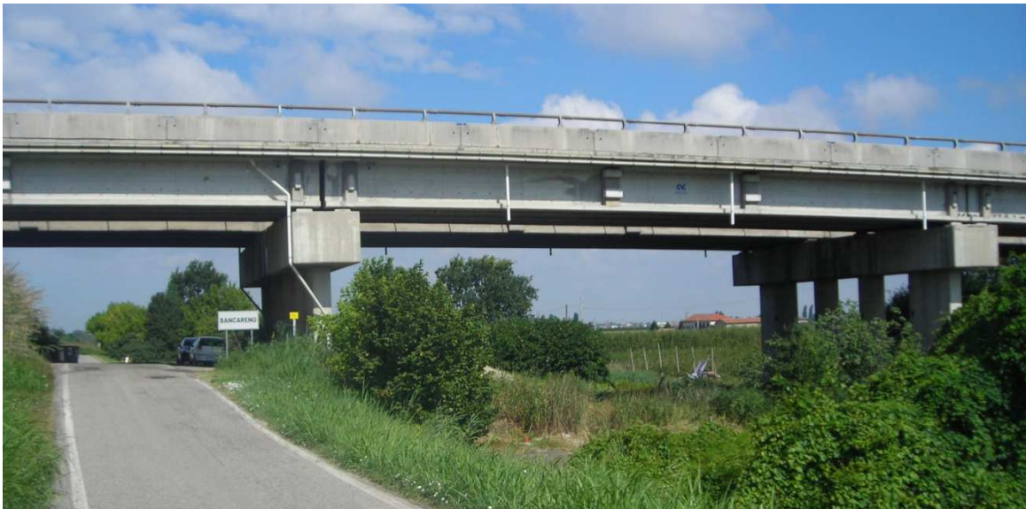
Figura 4: Ponte sul fiume Reno
