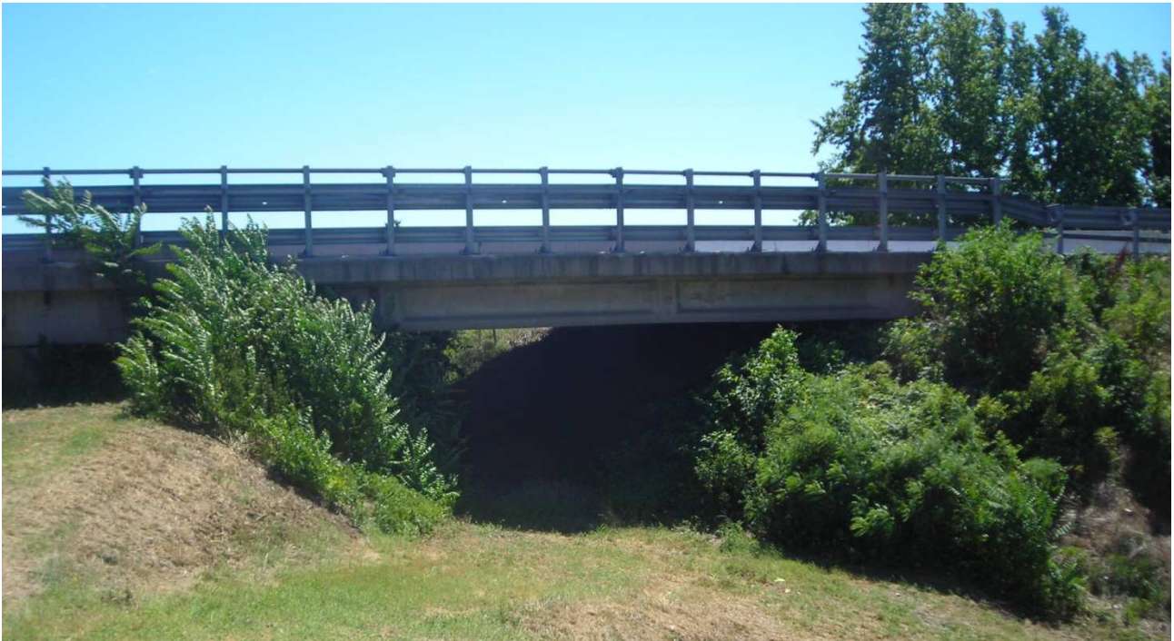
Figura 28: Ponte sul canale Navile – Pile esistenti
