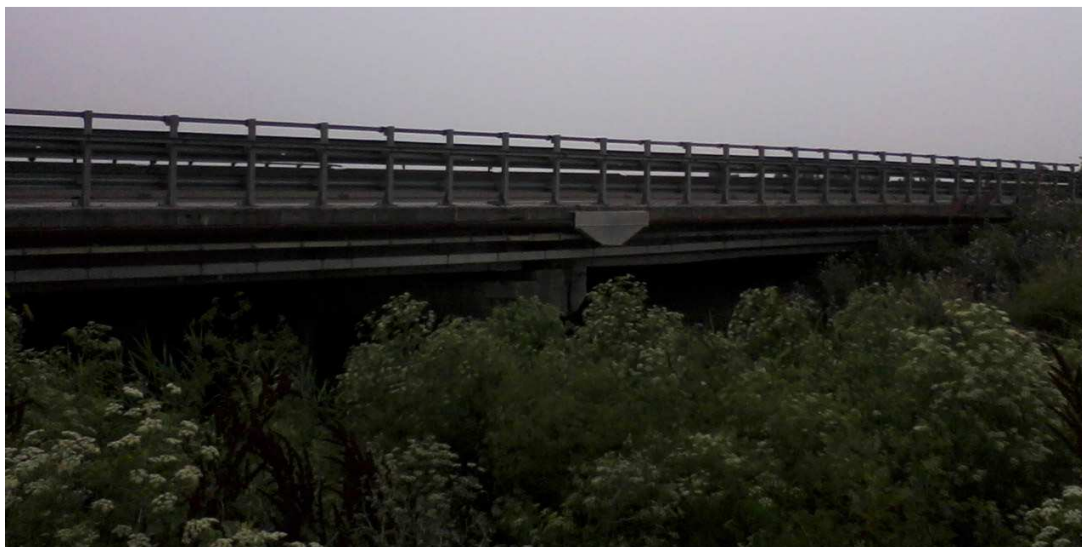
Figura 39: Ponte sul canale Diversivo
