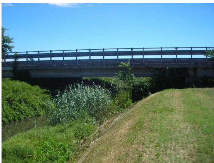
Figura 25: Canale Navile in corrispondenza del viadotto autostradale
