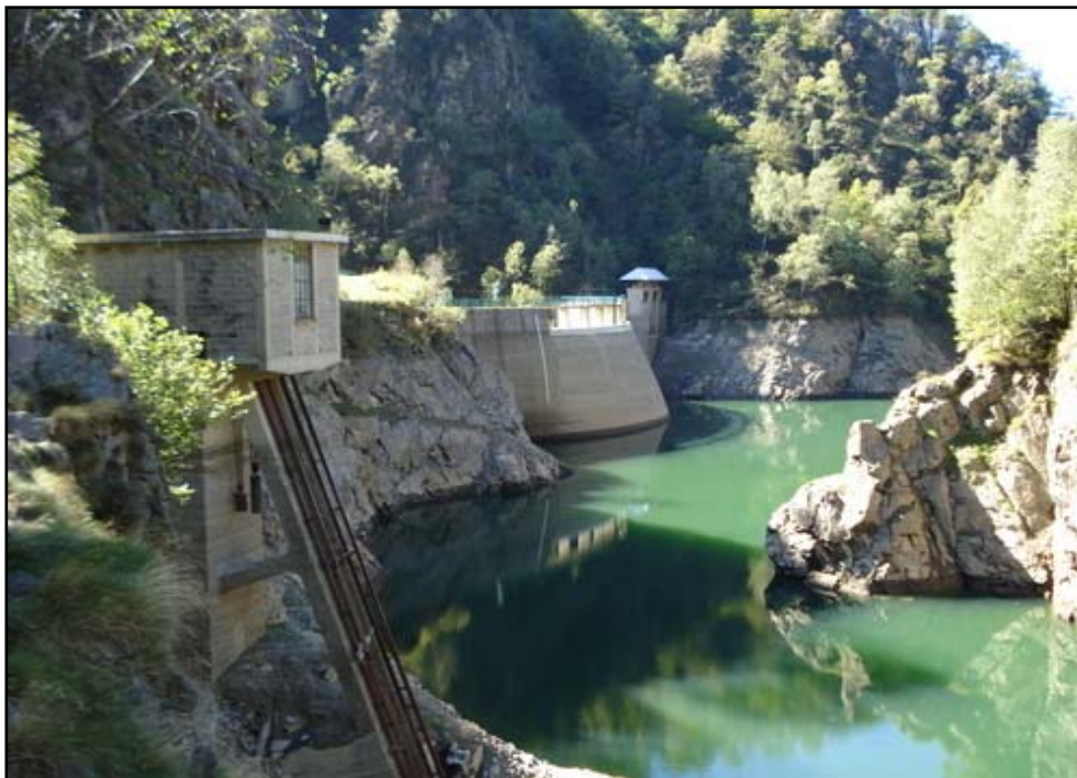
Fig. 4.1.1: La diga delle Mischie, Alta Val Sessera
