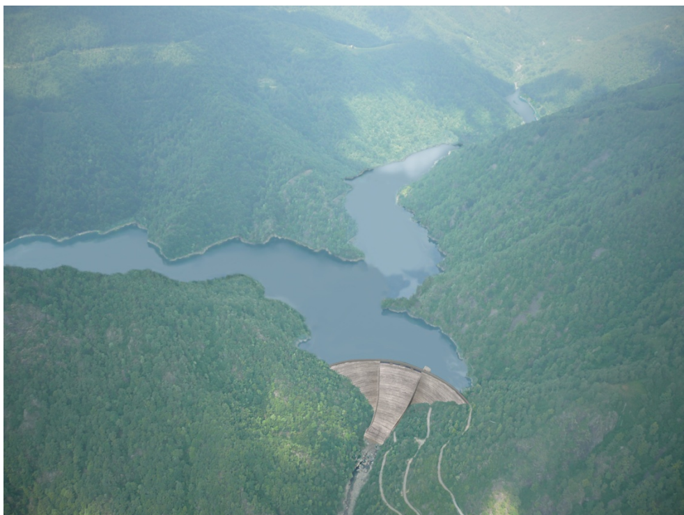
Figura 4.1.15 - Vista dall'alto nuovo sbarramento in condizioni di massimo invaso (asse Torrente Dolca). (cfr. foto 4.11.5)
