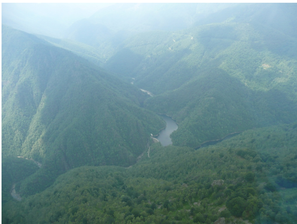
Figura 1.11.6 - Vista dall'alto dell'attuale diga delle Mischie (asse Torrente Sessera).
