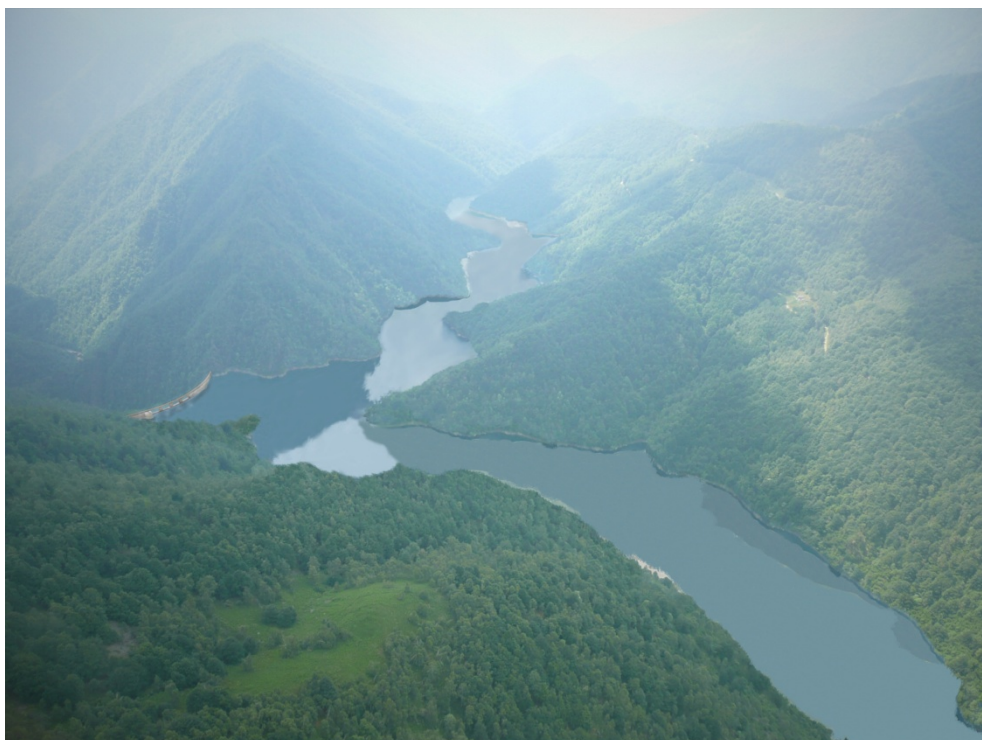
Figura 4.1.17 - Vista dall'alto e da monte invaso delle Mischie in condizioni di massimo invaso. (cfr. foto 4.11.7)
