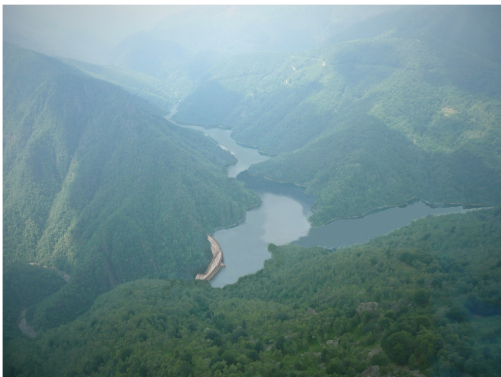
Figura 4.1.16 - Vista dall'alto diga delle Mischie in condizioni di massimo invaso (asse Torrente Sessera). (cfr. foto 4.11.6)
