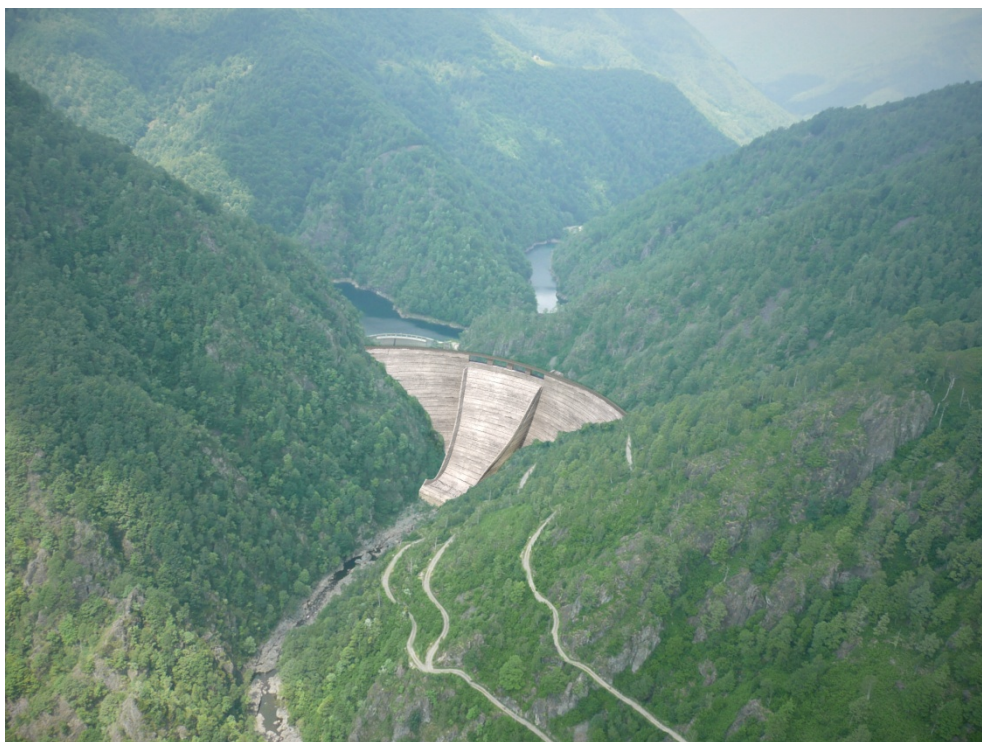
Figura 4.11.8 - Vista da valle nuovo sbarramento in condizioni pre-invaso. (cfr. foto 4.11.3)
