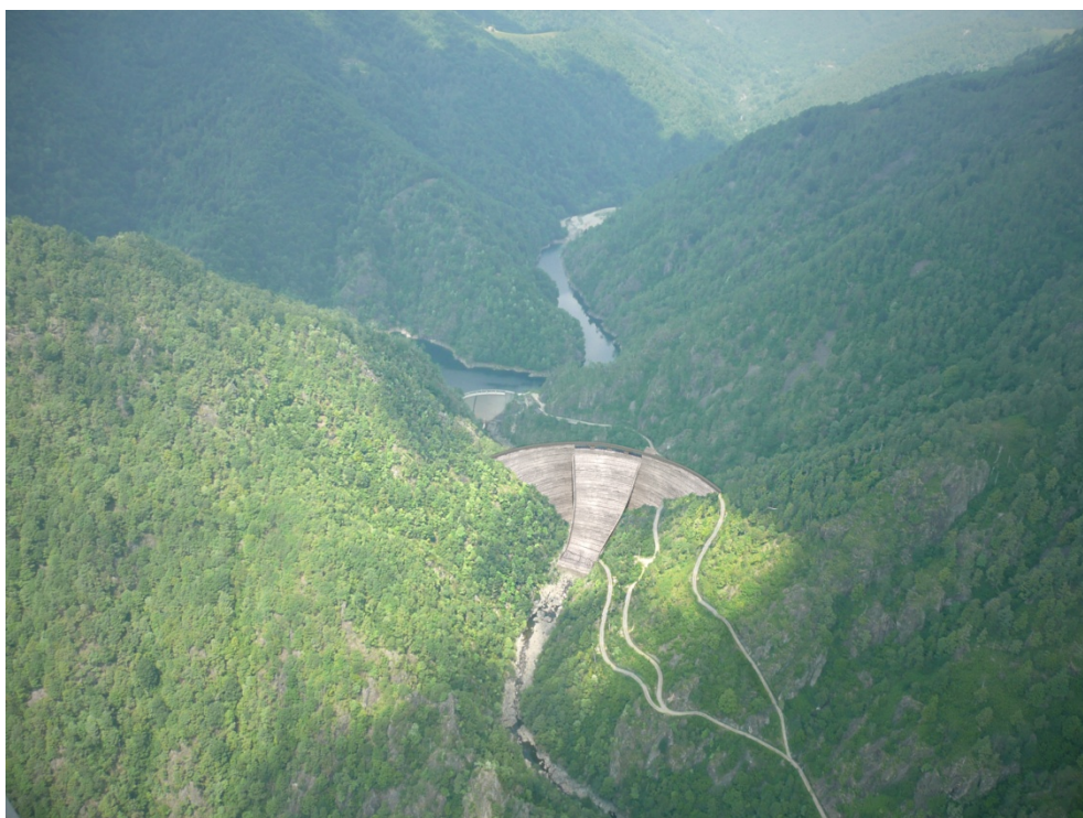
Figura 4.11.9 - Vista da valle nuovo sbarramento in condizioni pre-invaso. (cfr. foto 4.11.4)
