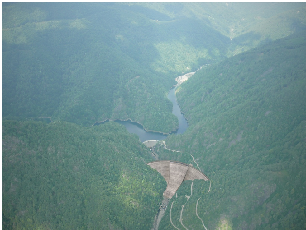
Figura 4.1.10 - Vista dall'alto nuovo sbarramento in condizioni di pre-invaso (asse Torrente Dolca). (cfr. foto 4.11.5)
