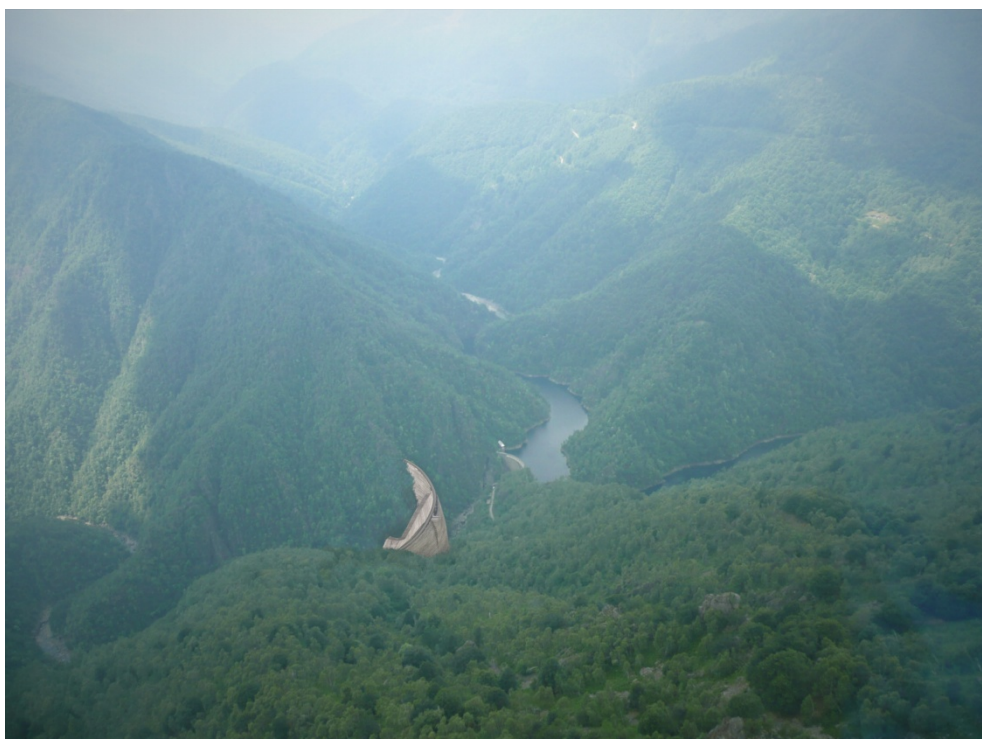
Figura 4.1.11 - Vista dall'alto diga delle Mischie in condizioni di pre-invaso (asse Torrente Sessera). (cfr. foto 4.11.6)
