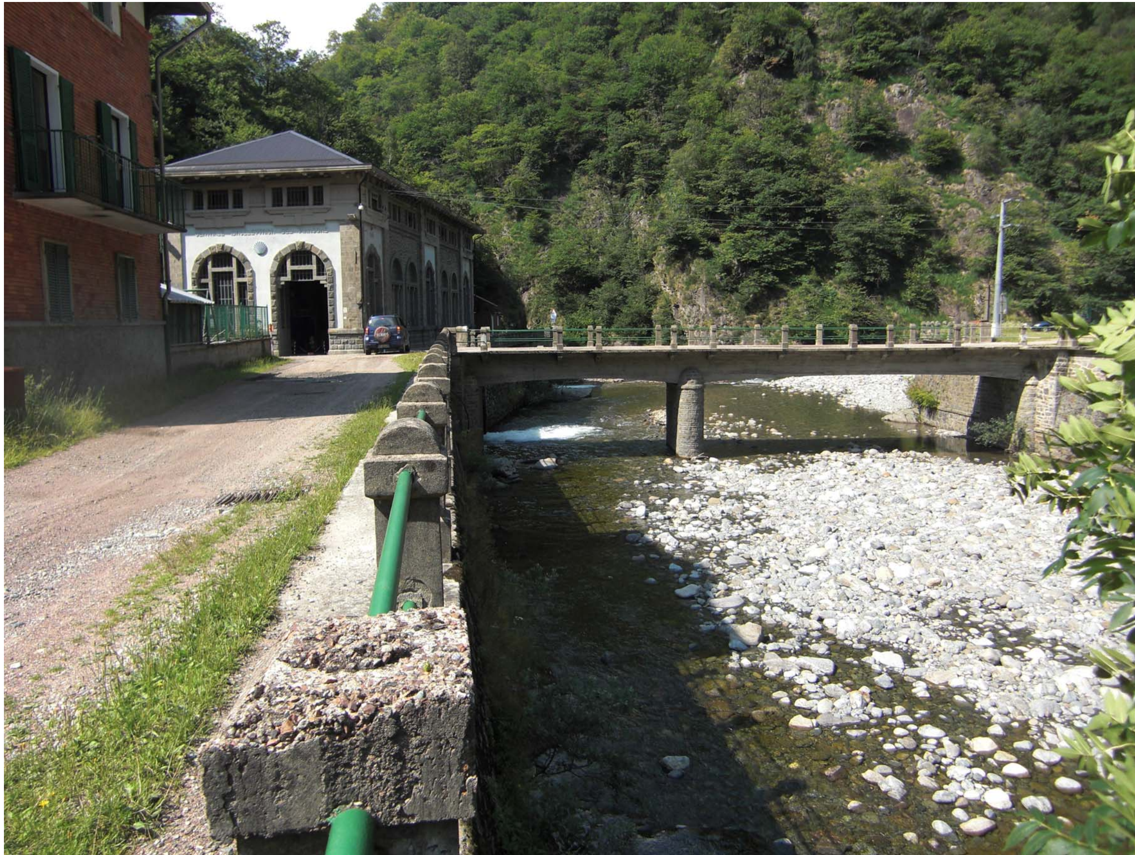
FIG. 4 La centrale idroelettrica Piancone 1
