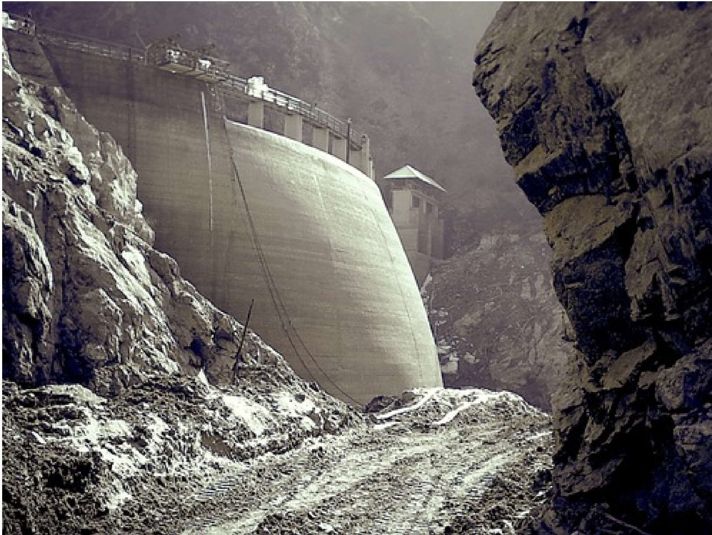
FIG.2 La diga delle Mischie in fase di ultimazione
