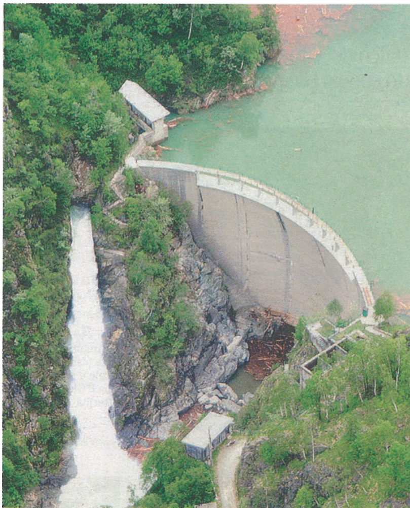
La diga sul Ravasanella fornisce acqua all'agricoltura
